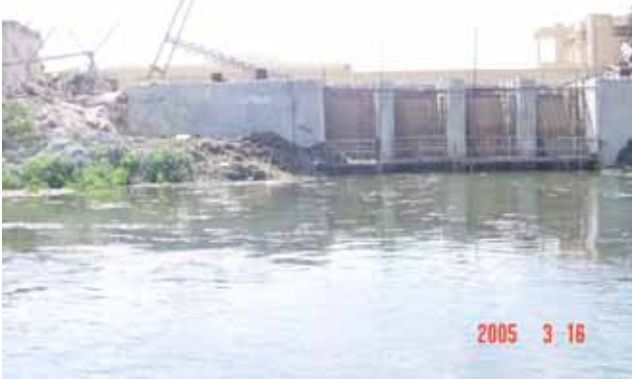
写真 13 ジャナクリス～ナハダ間運河 灌漑用水の取水路が多数ある
