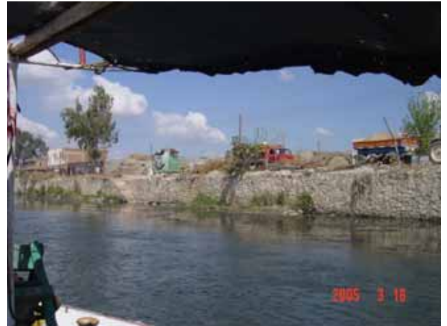
写真10 ジャナクリス～ナハダ間運河 左岸の直立石積護岸：後方に集落が見える。
