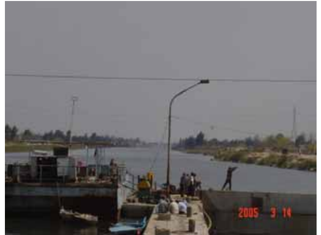
写真4 「ブスタン閘門」から上流を望む。左係留は工作作業台船
