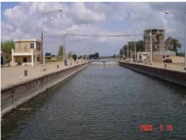
写真2 カナタール閘門から 40km 地点の「カタバ閘門」。右上：運河管理塔建設中。
