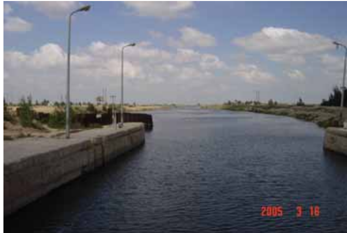
写真 - 4 ジャナクリス閘門から 下流側運河を写す。 閘門左にバラージと 水路あり、下流側 500m 区間は運河幅が広い。 右岸法面は 11km に亘り 石張護岸がされている。
