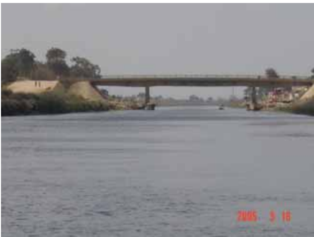
写真 14 ジャナクリス～ナハダ間運河 ヌバリア運河 90km 地点の高速道路橋 当橋の下流から運河水深が浅くなる
