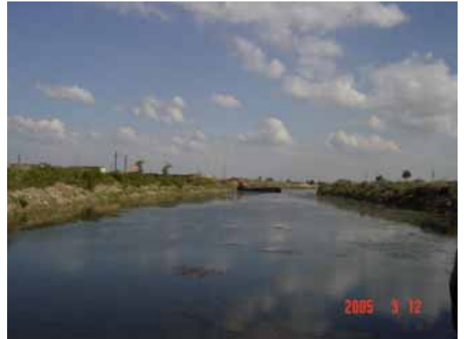
写真 16 ジャナクリス～ナハダ間運河 「ナハダ閘門」から上流。水草が浮いているのが見える。浮草除去作業を実施中（中央台船）
