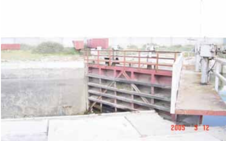
写真 - 12 ナハダ閘門のゲート。 閘門前後の水位差が6 m近く ある。
