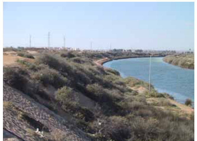
写真 18 ナハダ閘門から下流 運河は地上面下 5 m を流れる。法面勾配は 2 : 5 と緩い。
