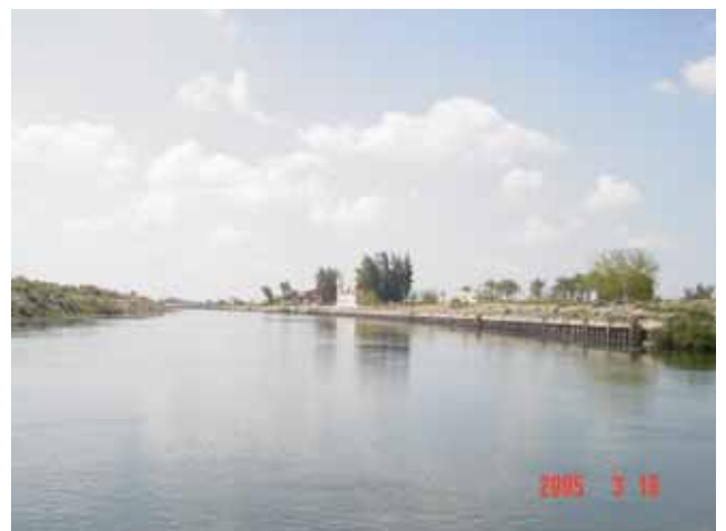
写真12 ジャナクリス～ナハダ間運河 右岸にシートパイルの直立護岸が見える。
