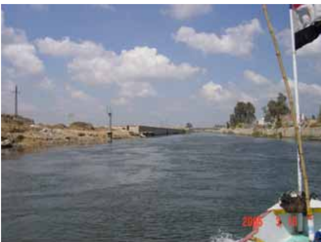
写真9 ジャナクリス～ナハダ間運河 右岸は石張護岸が続く。前方左岸には、航路標識（ビーコン）その先に直立の石積護岸が見える。
