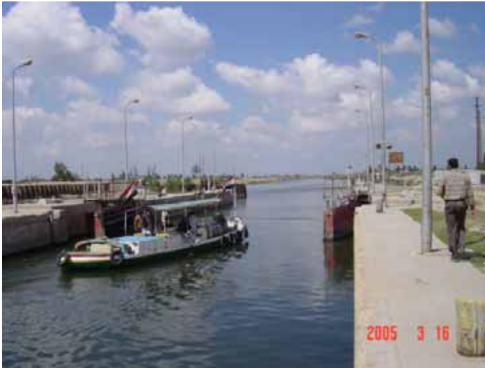
写真 - 4 ジャナクリス閘門から 下流側運河を写す。 閘門左にバラージと 水路あり、下流側 500m 区間は運河幅が広い。 右岸法面は 11km に亘り 石張護岸がされている。
