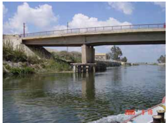
写真11 ジャナクリス～ナハダ間運河 当運河区間には高速道路橋が4橋架かる。
