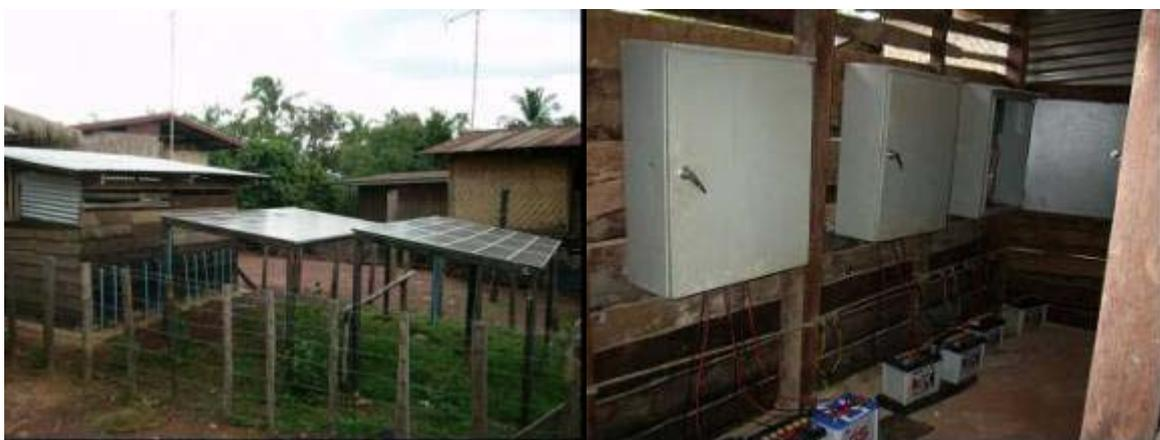
ラオスでは JICA パイロット村落のうち、BCS だけを設置している 2 つの村とも予想以上に上手に利用されていた。この BCS は村人が所有する自動車用バッテリーを充電するだけというシンプルなビジネスモデルである。村落中心に設置された BCS 設備はきちんと維持管理され故障は発生していない。住宅が密集しているため電池を運搬する距離が短く運搬についての不満は出ていない。バッテリー充電料金や充電のルールは住民が自主的に設定し、事業者には村が定額の BCS 利用料金を支払っている。このように、BCS を住民だけで運営できるという事例が確認できたことは今後の開発アプローチの検討に大いに役立つ。
