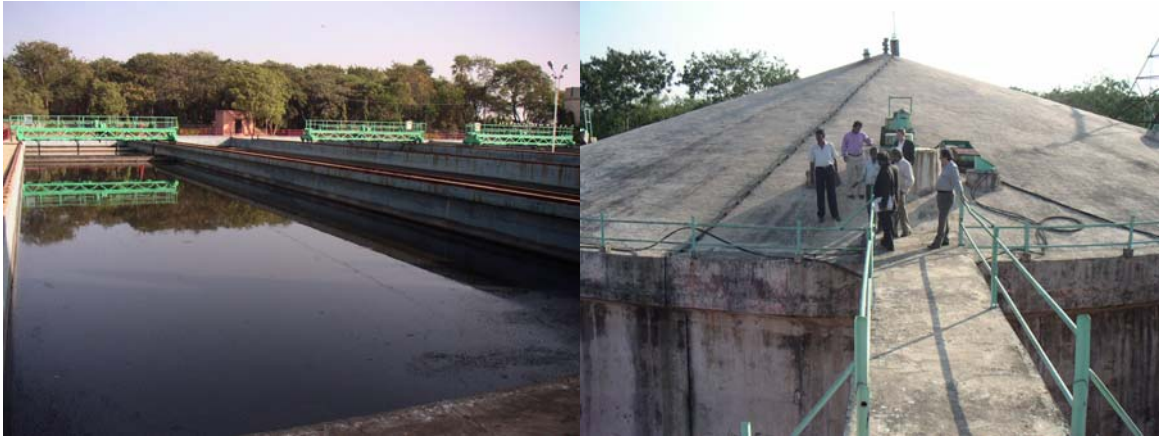
1次処理施設と Sludge Digester
