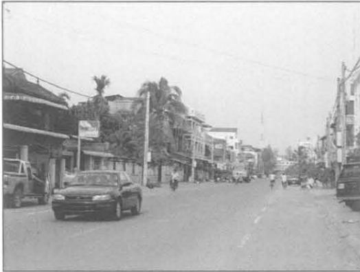
プノンペン市が自ら積極的に整備を進めている都心集散道路の舗装化
