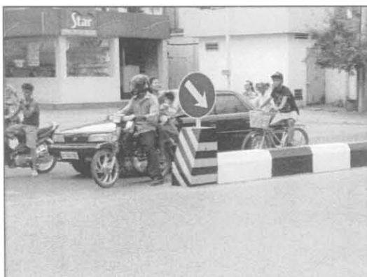
中央分離帯の設置(一部には設置に非難もあるが、逆行レーン走行や交差点以外の左折を制限し一定の効果을あげている)
