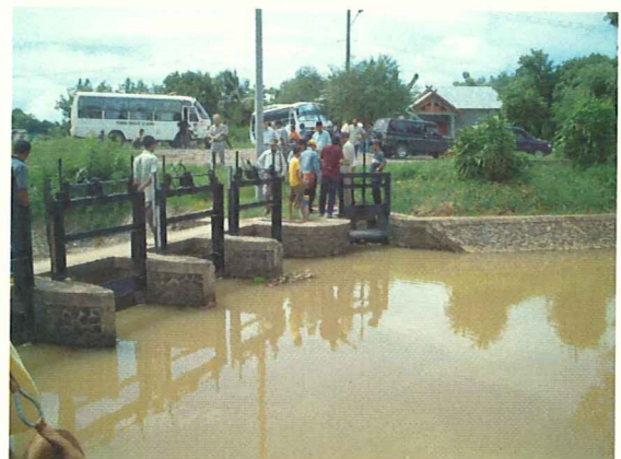
写真 6. 二次水路取水口
