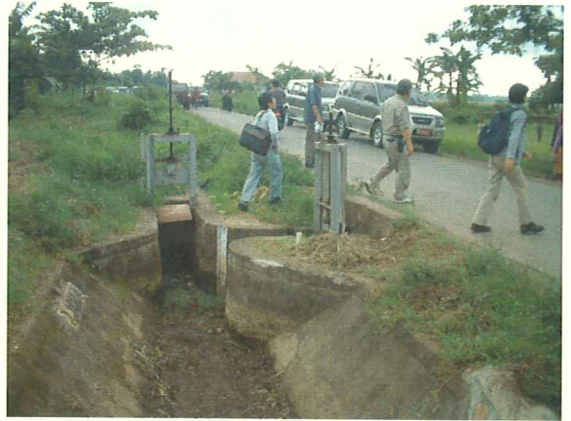
写真 8. 三次水路への分水工
