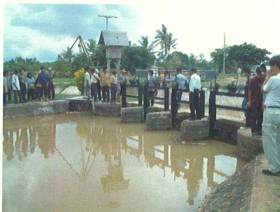
写真 5. 二次水路への分水工
