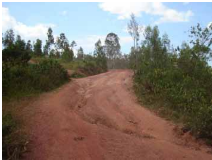
路面の凹凸の著しい地方運行路線(キブンゴ) 路面の凹凸が著しく民間バス業者のミニバスでは通行困難な地方運行路線。走行する大型バス車体への負荷が大きい。雨期は路面状態が更に悪化し通行が困難となる。
