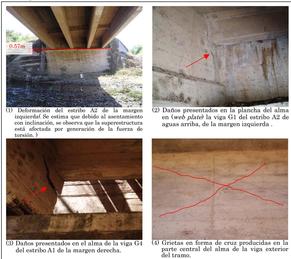
Foto 2.2.2.1-1: Estado de Daños Presentados en las Vigas de la Superestructura
