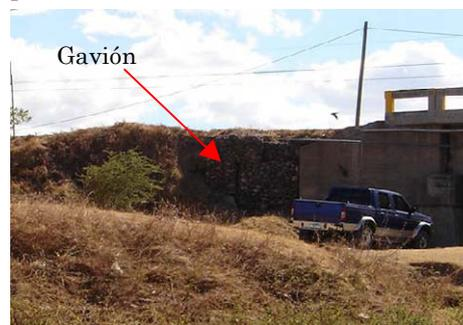
Foto2.2.2.1-4: Refuerzo Provisional de Terraplén del Estribo a base de gavión.
