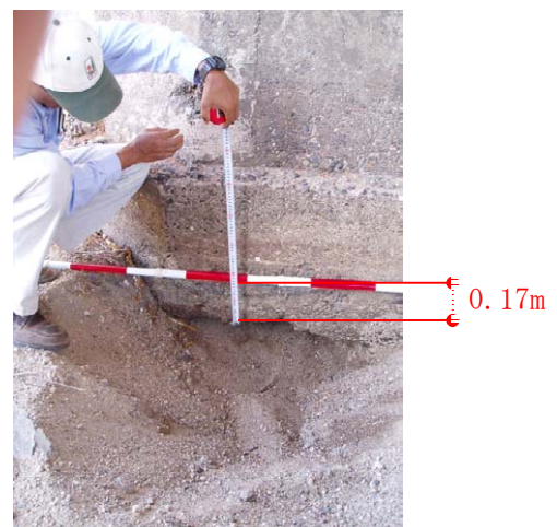
写真 3.2.2.1-2 A2 橋台の基礎の根入れ
