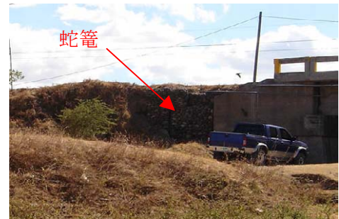
写真 3.2.2.1-3 蛇籠による橋台盛土の応急補強
