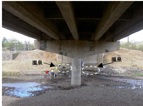
支間長、橋梁幅に比べて細い橋脚
