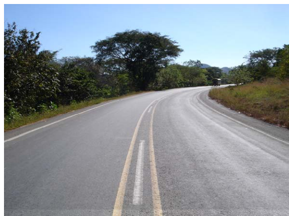
CA-1号線の路面状況 (アスファルト舗装:良好)
