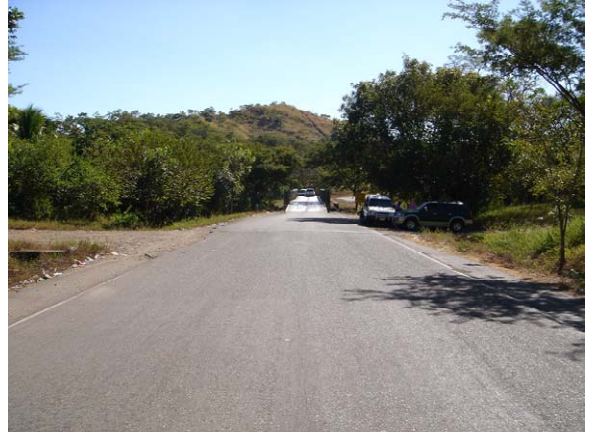
CA-3 号線の路面状況 (アスファルト舗装 : 良好)
