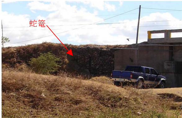
蛇籠による応急処置
