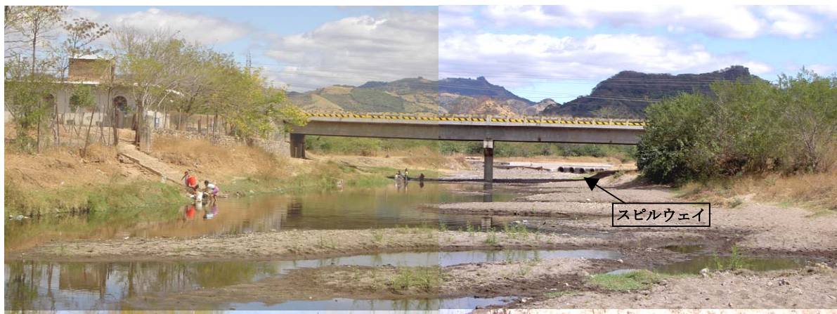
下流側から見た河道の状況及び上流側のスピルウェイ
