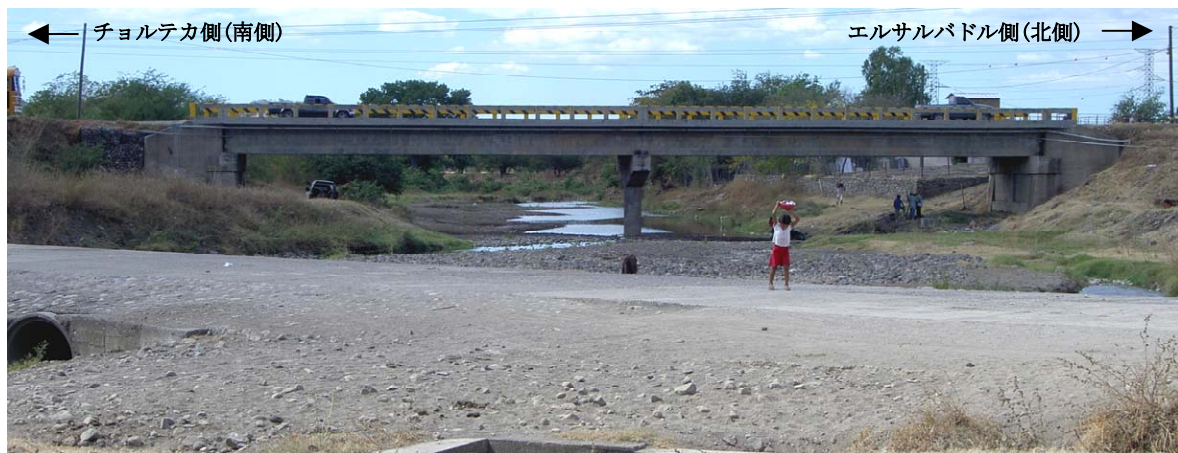
橋梁全景 (上流側から臨む)
