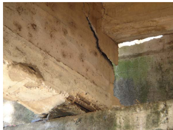
桁の損傷
