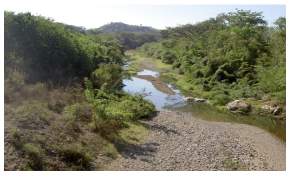
下流側河道の状況
