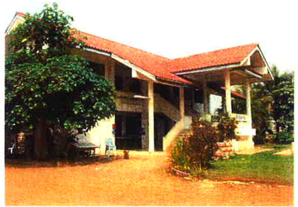
サムラン・サブステーション (1階がサブステーション、2階はヘルスポスト)
