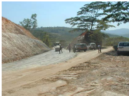
民生安定化支援短期専門家のグレノの 道路改修工事現場
