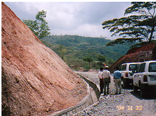
民生安定化支援短期専門家グレノ道路改修の 側溝工事現場
