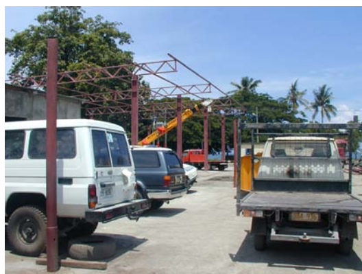
増築中の A1 ワークショップおよびクレーンと モバイルワークショップ
