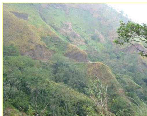
切土斜面をもつ山地部道路の全景
