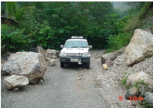
山地部道路の落石と山側斜面崩壊
