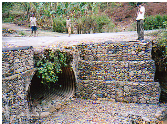
民生安定化支援短期専門家の横断排水工の 呑み吐き口の修繕工事現場
