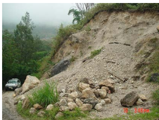
幹線道路の切土斜面の表層崩壊
