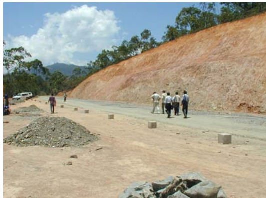
民生安定化支援短期専門家のレテホ木の 道路改修工事現場
