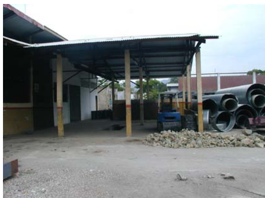
ディリ地方道路事務所にある MTCPW のサービスランプとホークリフ
