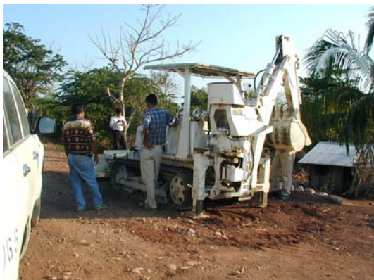
DRBFC の直営事業ドルバ～ジュマライ間の路面 修理に使用中の JEG 残置機材の小型ブルドーザ
