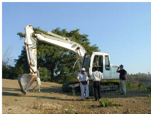
DRBFC の直営事業ドルバ～ジュマライ間の路面 修理に使用中の JEG 残置機材の油圧ショベル
