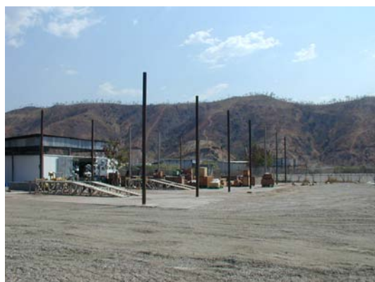
タシールキャンプ内に建設中のワークショップ
