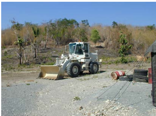
DRBFC の直営事業ベコ～ロロイ間の新設道路 建設に使用中の JEG 残置機材のホイールローダー
