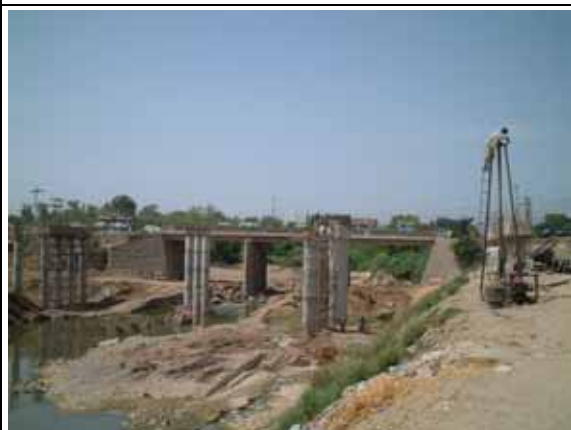
カタリアン橋 下流左岸より撮影
