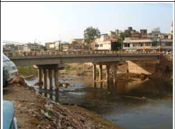
ガウルマンディ橋 水位計設置予定地より撮影
