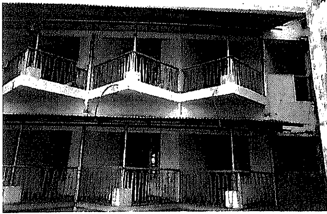
プンツォリン県病院：インドとの国境都市、南部の気候に即した風通しを考慮に入れた設計で、窓毎に各ベッドが配置されている
