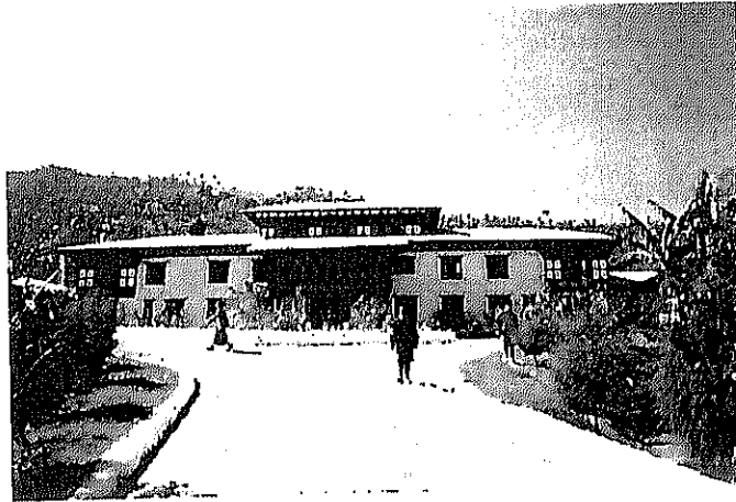
ブナカ県病院：ドイツの NGO の援助で建設され、1996 年に診療開始した比較的新しい 20 床の病院 大手術の場合には、首都ティンブーの JDWNR 国立病院から外科医が派遣される
