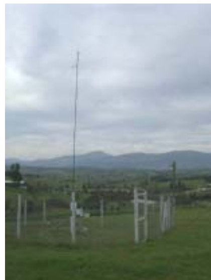
ローカルエネルギーとして検討されている風力発電。PECA 内に設置されている。
