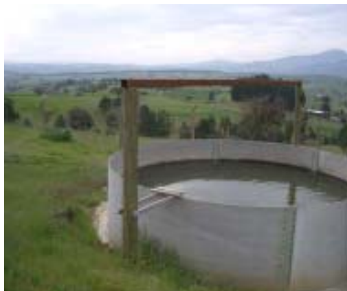
PECA に設置された貯水槽。PECA に隣接する谷に試掘された深井戸から揚水されているが、期待された揚水量を得るには至らなかった。
