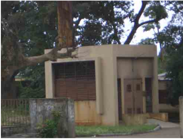
国立ドンカ病院 焼却炉
