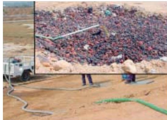
写真2-8 メキシコ市の埋立処分場における浸出水の再循環処理設備
