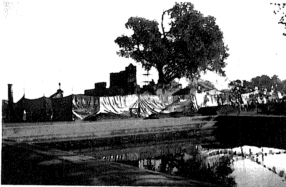
写真-3.19：ルンビニ、マヤ堂の修復
