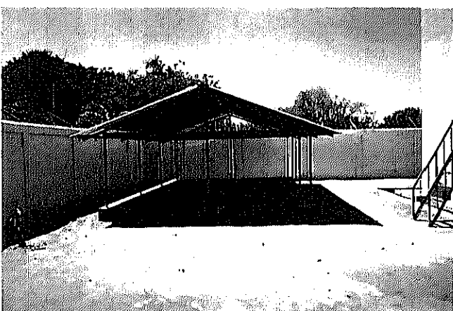
乾燥汚泥貯留槽
