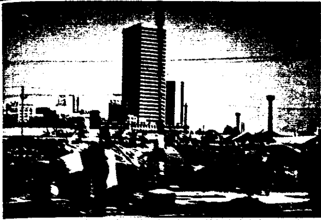
ダッカ市内 高層ビル建設中。手前都市流入市民簡易住い。
