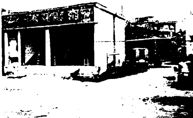
チッタゴン市内 セメント商店。在車が確認された。('91.5.28)
