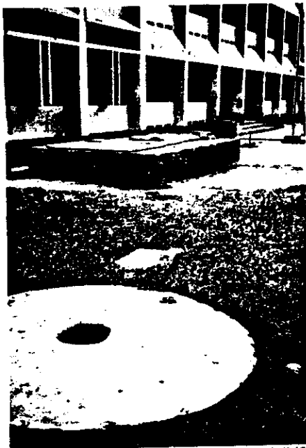
上記小学校 受水槽タンク及び浄化槽
