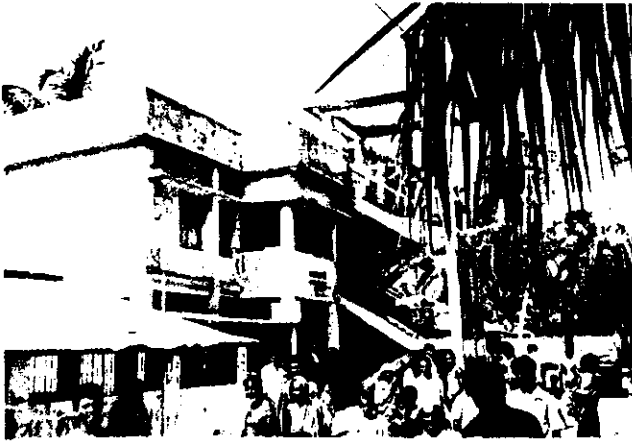
既存 サイクロンシェルター兼小学校
