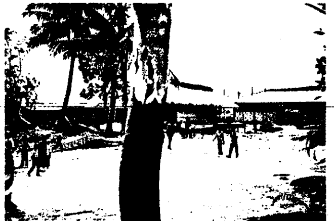
サイクロンにて壊れた中学校 一部再建新築している。
