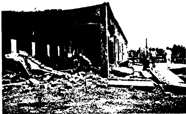
チッタゴン港湾地区 サイクロンの被害を受けた小学校 パッカータイプ
