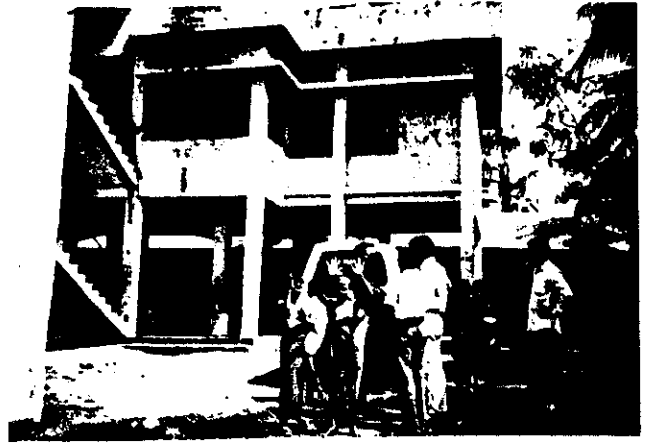
サイクロンシェルター兼ローバースカウト事務所
