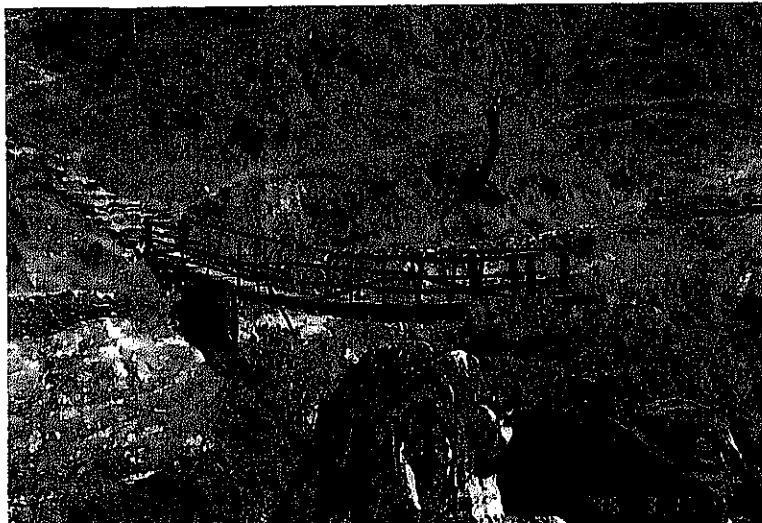
ラメチャップ郡 ナマディー村 —壊れかかった木製の橋
