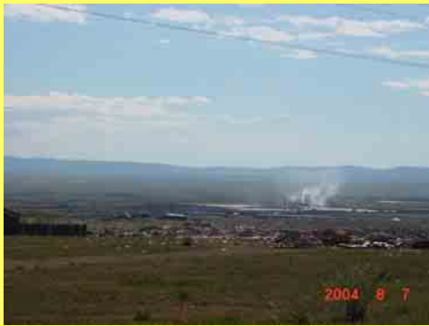
Nalaikh地区最終処分場
