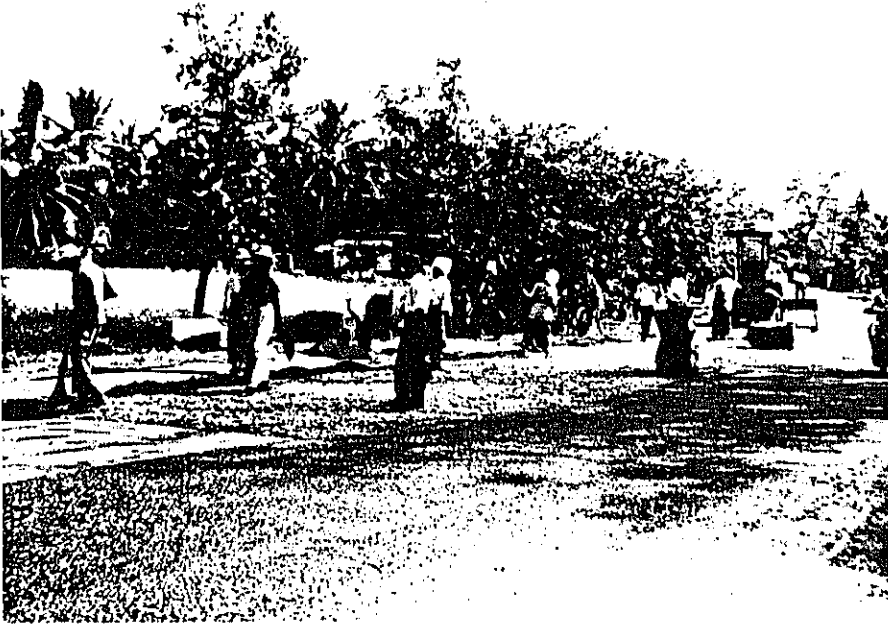
写真 ⑮ アマラドハブラ付近 舗装工事状況
