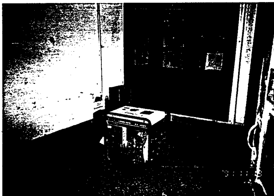
Barki RHC 非常用発電機
