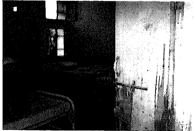
市民病院（二次医療施設） 洪水により病棟のドアが壊れたまま放置されている。
