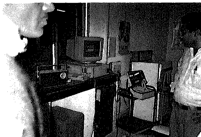
市民病院（二次医療施設） ICU内の看護室では、中央監視装置が稼働している。 機材は比較的充実している。
