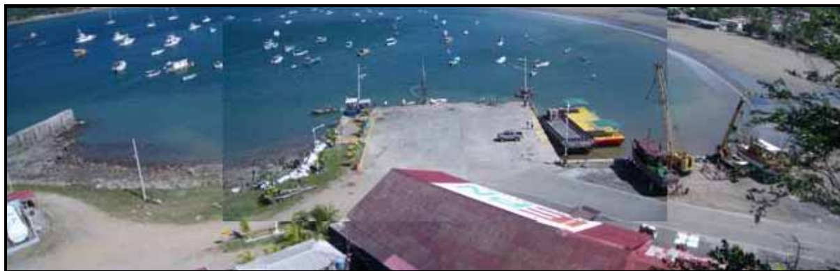
写真—1 岸壁の全景
