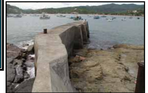
防波堤（陸側端より）
