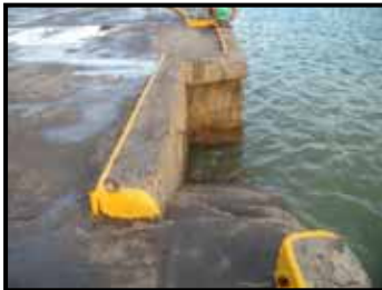
岸壁と階段（南東端より）
