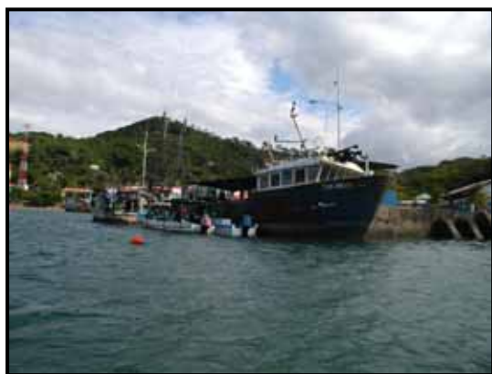
写真—3 岸壁係船状況
