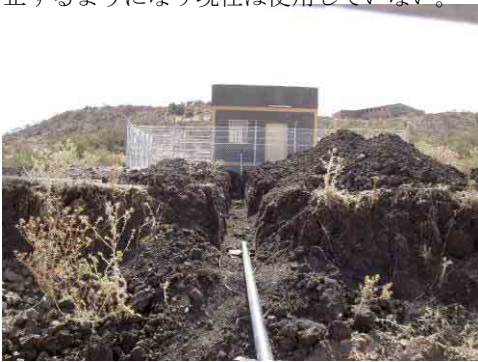
写真-5 ECDF による深井戸 B-18 建設中のため未稼働。現在送電線と市内までの導水管を埋設中。
