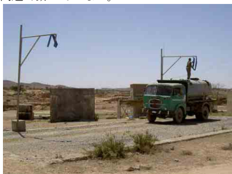
写真-21 深井戸 BH-14 ECDF によりリハビリが行われ、タンカー給水施設と付近の Ad Golgol 村用の公共水栓が設置された。
