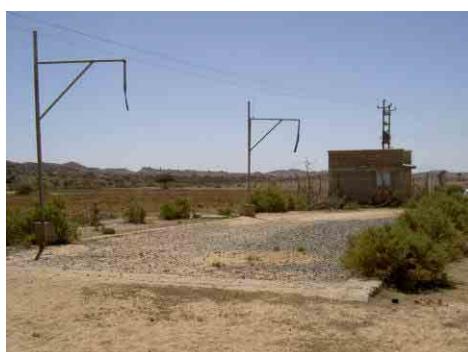
写真-19 JICA 開発調査による深井戸 DEK-1 ECDF が 2001 年にタンカー給水用施設を整備した。一日にタンカー4台が利用していたが、井戸孔内のメカニカルな問題で動いていない。
