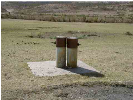
写真-27 JICA 開発調査による深井戸 ADI-1 水位計を設置できる構造となっているが、水位計は無い。 密封されており使用されていない。使用予定。
