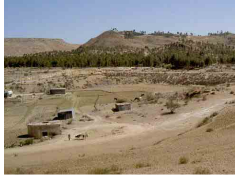
写真-26 DW-1とDW-2およびイタリアによるダム ダムは近年水が溜まっていない。ダムの下流に浅井戸 DW-1とDW-2があり、DW-2のみタンカー給水と市内 配水網の水源として計42m 3 /day程度揚水されている。
