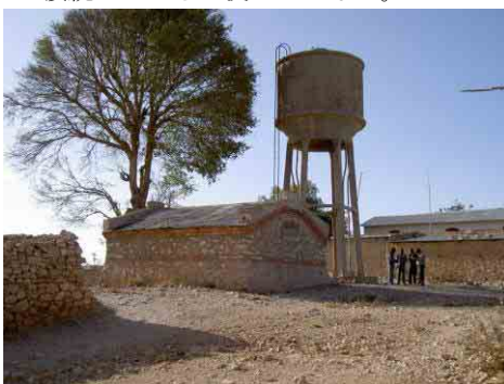
写真-31 給水塔と配水タンク（隣接） 給水塔（50m 3 ）は BH-7 を水源とし市の中央から北部 に、地上設置型の配水タンク（100m 3 ）は DW-2 を水源 とし市の南部に給水している。
