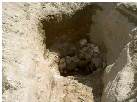
写真-11 ワジ底のピット 深井戸 PW-1 傍を流れるワジの河床に深さ 2.5m 程度のピットを掘り、飲料水として取水している。
