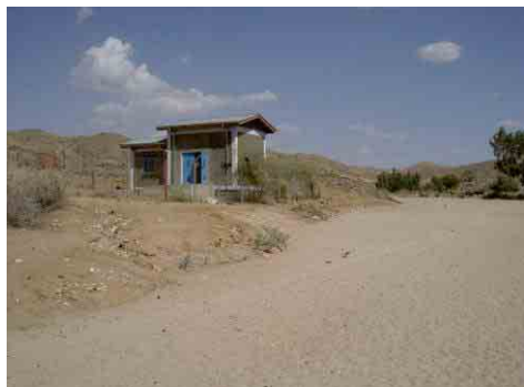
写真-13 ECDF による深井戸 PW-1 ECDF により 2000 年 11 月に掘削、2003 年にエンジン駆動のパーティカルポンプが設置され、近くの公共水栓 1ヶ所に送水している。現在、市の給水事業の唯一の水源である。
