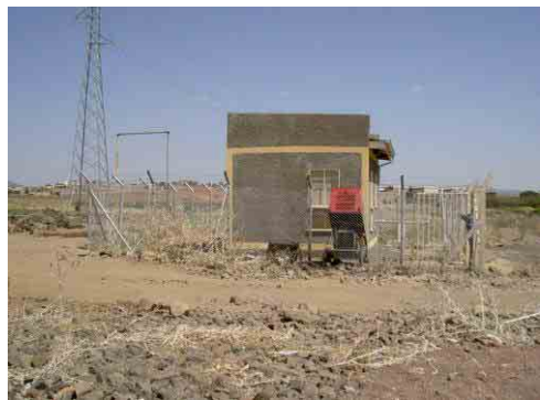
写真-4 ECDF による深井戸 B-07 タンカー給水で稼働している。現在の一日の取水量はタンカー16台で100m 3 程度。現在市内までの導水管を埋設中。
