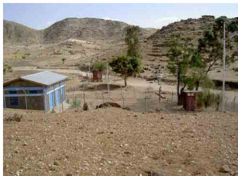
写真-15 ECDF による深井戸 PW-2 と PW-3 ECDF により 2000 年 11 月に PW-2(2.50/s)と PW-3(1.50/s)が掘削された。両井戸はワジ沿いに 50m 間隔で位置している。左側の建物内部には発電機が設置されている。
