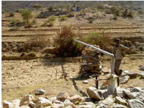
写真-28 JICA 開発調査による深井戸 ADI-2 水中ポンプと発電機が設置されており、タンカー給水で 使用されている。一日にタンカー3台のみが使用。
