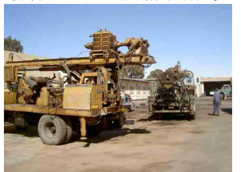
写真-40 ECDC社の資機材置き場（アスマラ） ECDF社は井戸掘削用のリグを10台所有している。
