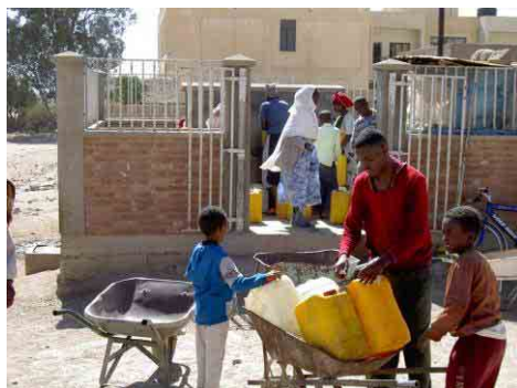
写真-23 HADAMU 地区公共水栓 ECDF が 2001 年 7 月に建設した公共水栓。蛇口 8 個。ECDF は HADAMU 地区に独立した給水施設（深井戸 1 本、配水タンク 50m 3 、公共水栓 1 個）を設置した。
