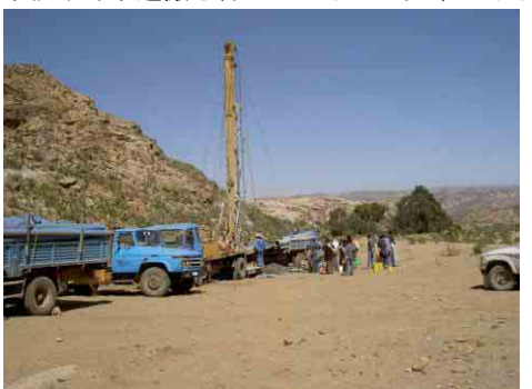
写真-39 井戸掘削現場（アディケイ） ECDFによる中国企業（Complant社）の井戸掘削現場。アディケイで7本目を掘削中であつたが、1本も成功井が得られなかった。
