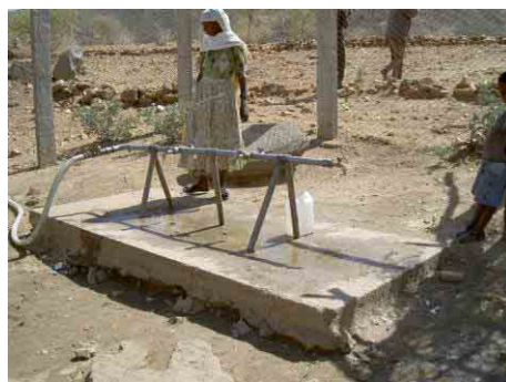
写真-14 マイディマに唯一の公共水栓 左の写真に示す深井戸から工事用のテンポラーなビニール張りの配水タンク (30m 3 ) に貯めて、この公共水栓 1ヶ所のみで給水している。ロバで市街地まで運搬する。
