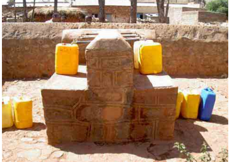
写真-8 公共水栓 既存の公共水栓。蛇口6個。稼働時間は水源不足により平均3hr/dayで給水量は2.5~5m 3 /day。既存公共水栓8ヶ所中7ヶ所が稼働し、新規3ヶ所をECDFが建設中。
