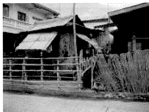
洪水により被害を受けた家屋
