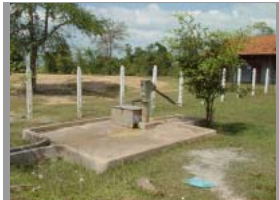
井戸 (ヘルスセンターに設置)
