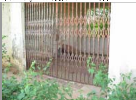
揚水機場外観
