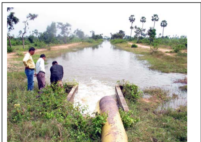
写真：トンレ・バティ・ポンプ灌漑システム ( 第 8 機場と幹線水路 )、11 月 18 日
