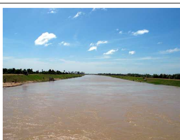
写真：ADB によって 2002 年までにプレクトノット川下流に建設された放水路。容量は約 200 m 3 /s。下流部の洪水被害軽減に効果を発揮している。
