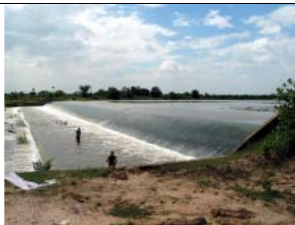
写真-4: 2003年10月28日。プレクトノット川左岸側にある Ou Krang Ambel 貯水池の余水吐。この灌漑システムはプレクトノット川支流とローレンチェリ北岸（左岸）幹線水路からの水を受けている。
