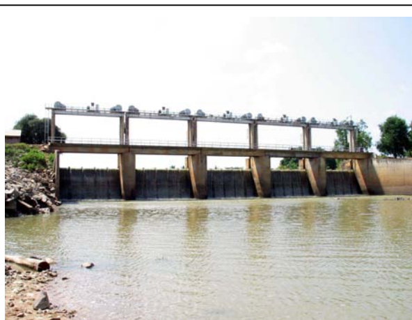
写真：11月19日のローレンチェリ堰（ゲート上の越流水深0.12m）
