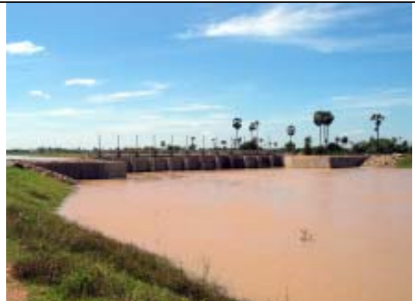
写真-2: 2003年10月28日。ADBの緊急洪水対策プロジェクトによってプレクトノット川の下流に建設された放水路。流下能力は 300 m 3 /s。
