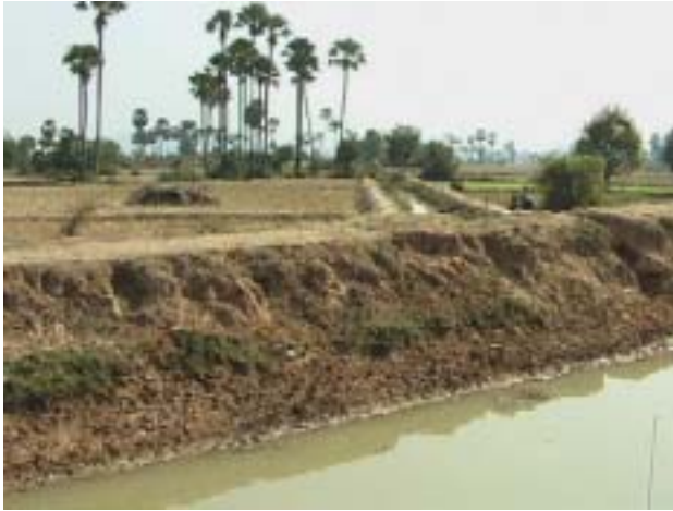
写真 1 - 1 3 右岸幹線用水路
