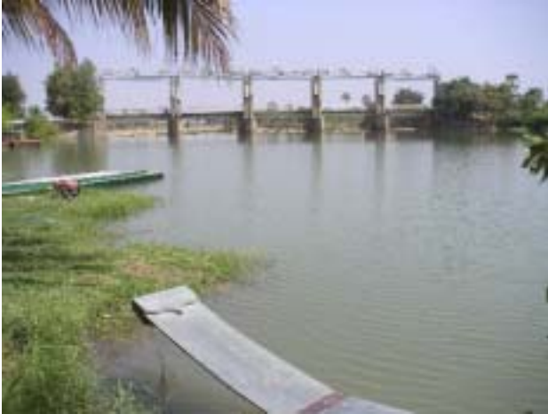
写真 1 - 1 ローレンチェリゲート全景 (上流より撮影)
