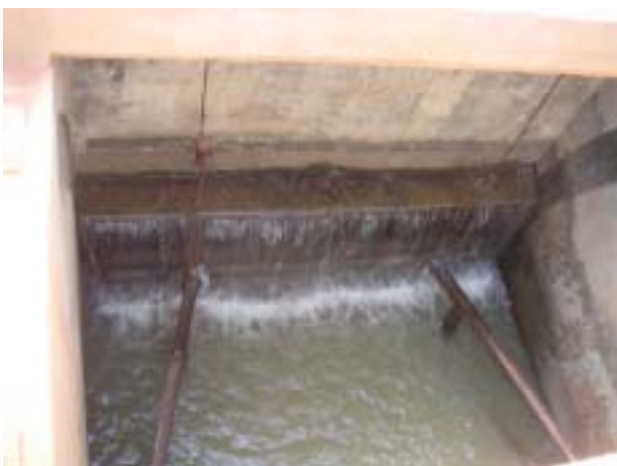
写真 1 - 1 2 右岸幹線用水路 取水口ゲート
