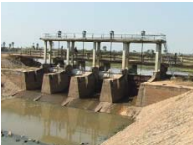
写真 1 - 9 Ou Krang Ambel (調整池) の ゲート
