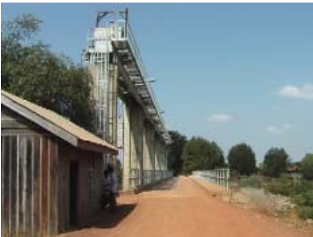
写真 1 - 2 ローレンチェリゲート (横断道路)
