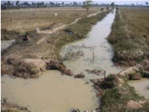
写真 1 - 1 0 左岸幹線用水路 二次水路（農家が建設）
