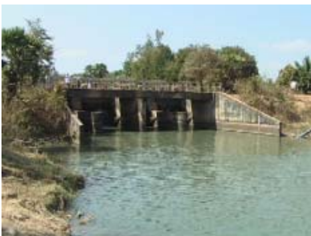
写真 1 - 6 左岸幹線用水路 取水口
