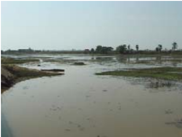
写真 1 - 8 Ou Krang Ambel (調整池)
