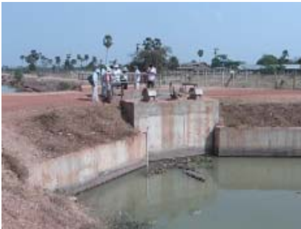
写真 1 - 1 1 右岸幹線用水路 取水口
