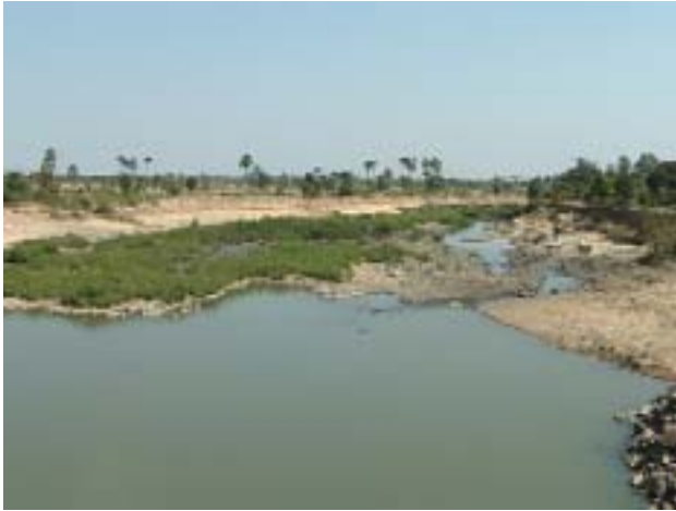
写真 1 - 4 ローレンチェリゲート下流側の様子
