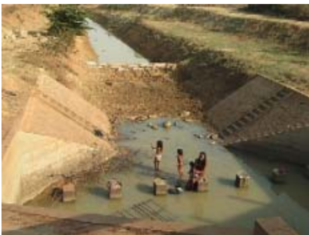
写真 1 - 1 5 右岸幹線用水路 取水堰
