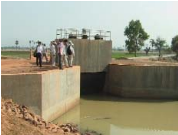
写真 1 - 1 4 右岸幹線用水路 取水堰
