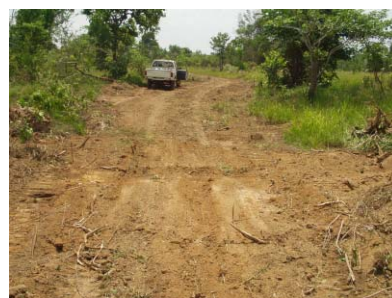
建設された進入路
