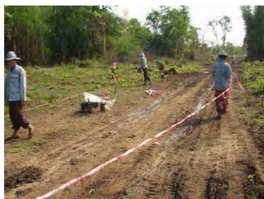
地雷原位置確認テープ張り
