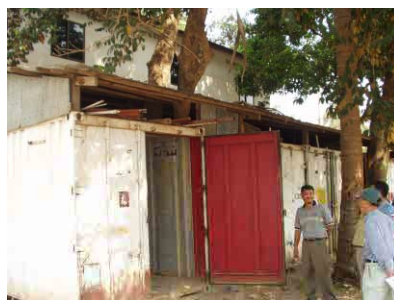
コンテナ倉庫 暑さ除け屋根を設置
