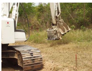
両側の伐開 (合計幅約 18m)
