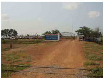
国道 5 号線沿いの正面玄関
