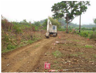
伐開状況（道路から片側約 7m）
