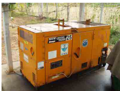
照明用発電機 20KVA
