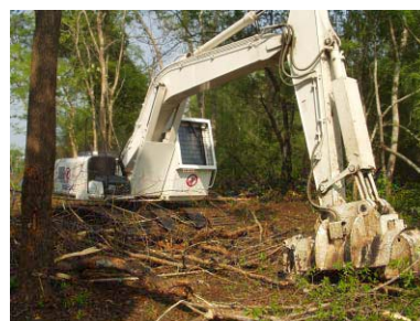
伐開状況（立木を掴んで排出）
