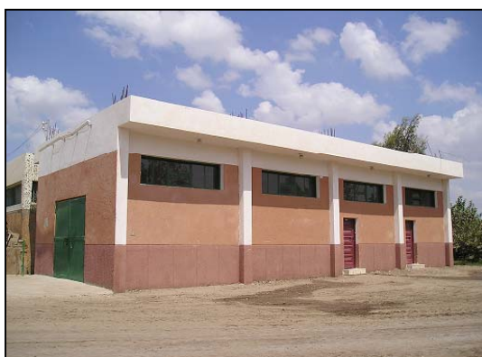
写真-15 Sakha(サハ) AMSにて 2KR見返り資金を用い、25カ所のAMSの整備 を行った際に建てられたセントラル・スペア・ パーツ保管倉庫(管轄地域の核となる倉庫)
