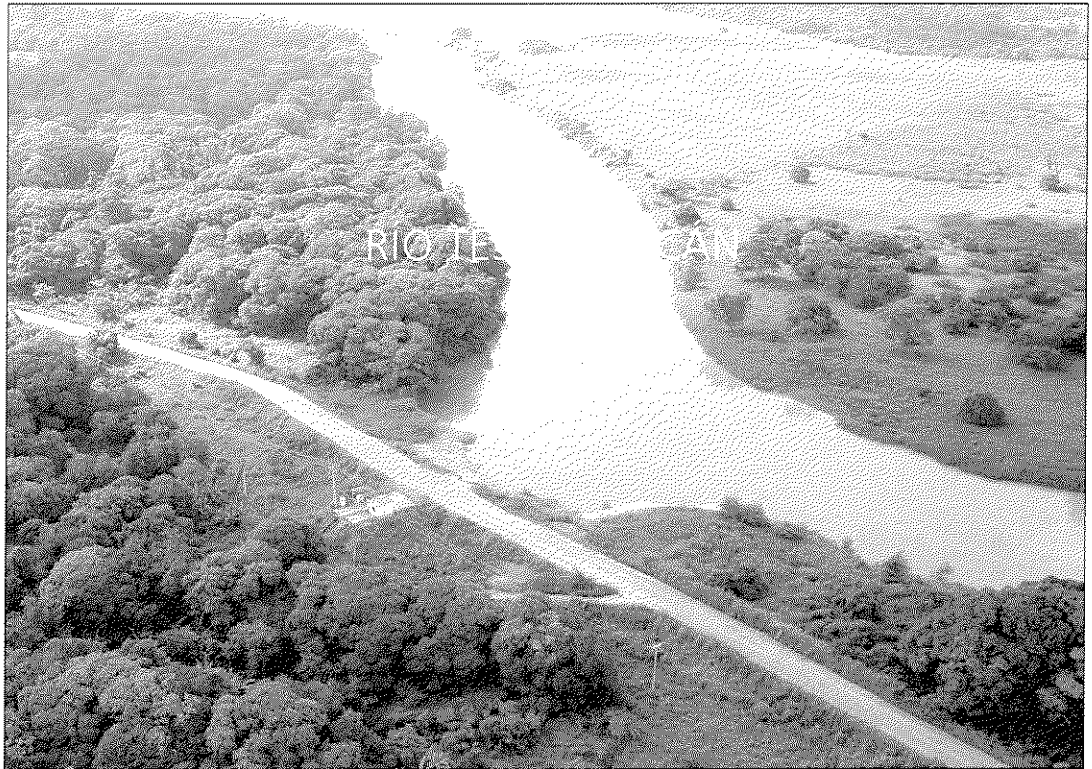
CÁRCAMO Y ESTACIÓN DE BOMBEO SUBMODULO TESECHOACÁN
