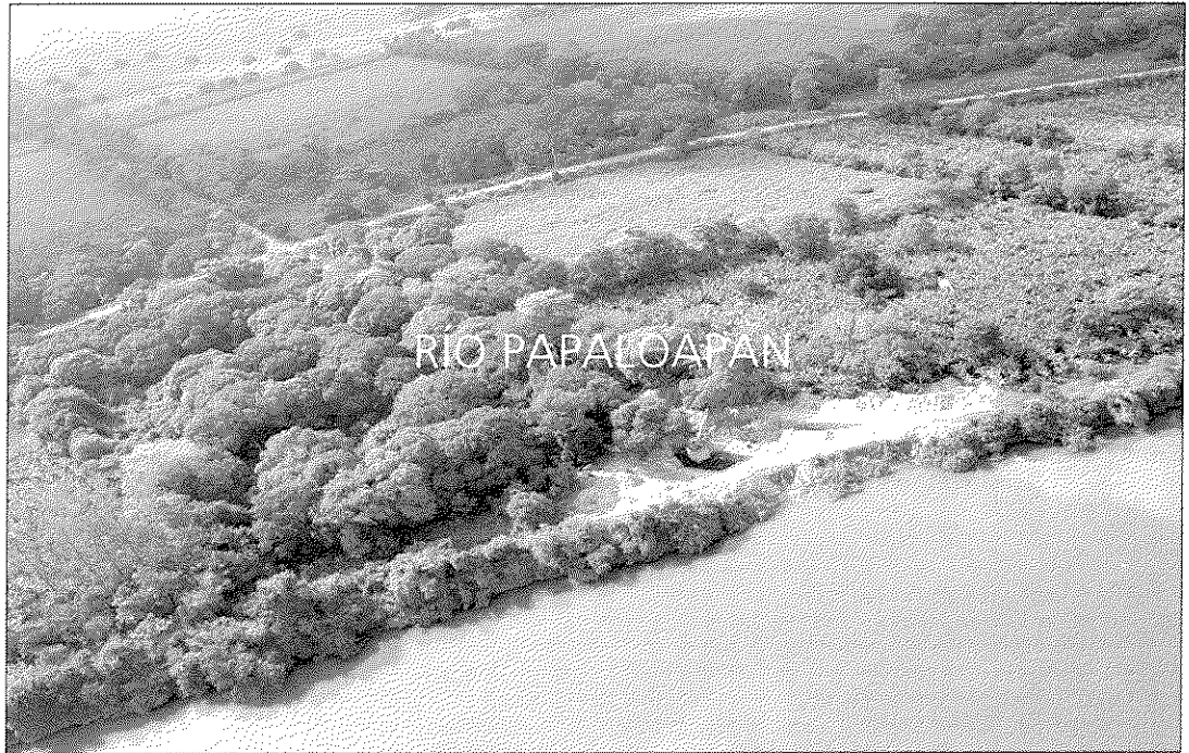
CÁRCAMO Y ESTACIÓN DE BOMBEO SUBMODULO TLACOJALPAN II
