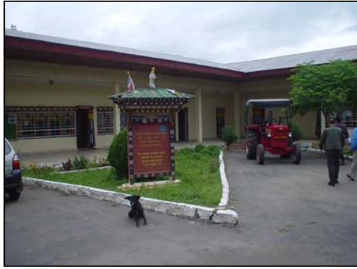
写真 13 : パロにある AMC 農業機械 トレーニングセンター建物
