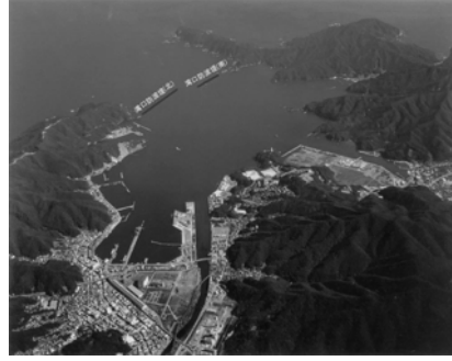
○Tsunami Breakwater (Kamaishi Port, Iwate Pref.)
