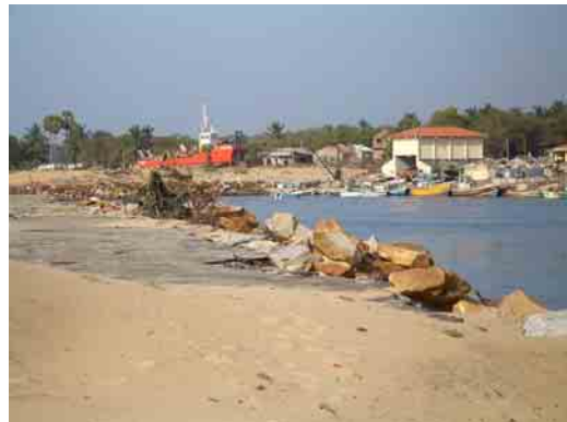
キリンダ漁港の浚渫船
