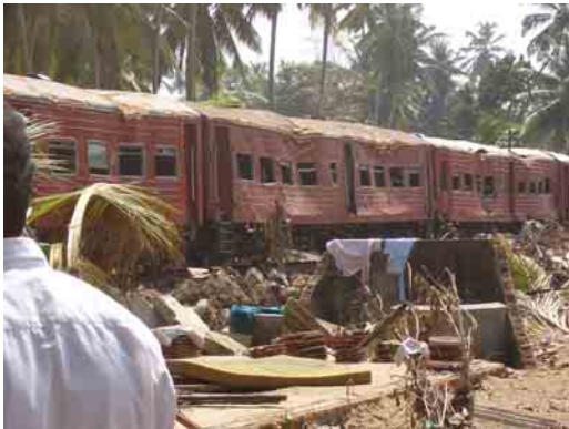
Hikkadua (南西部) 沿岸近くの線路
