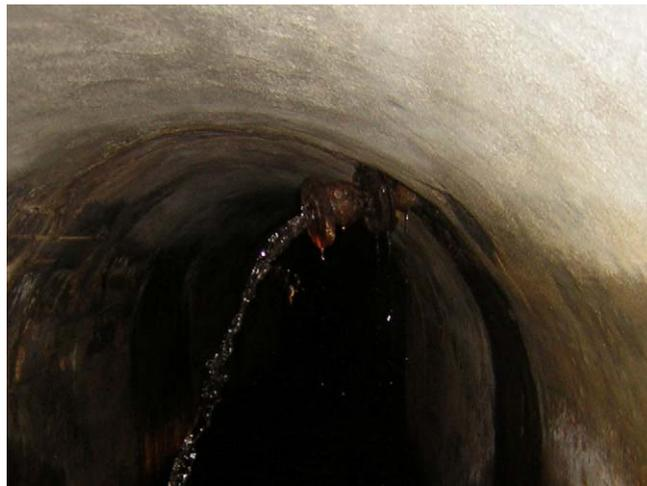
図 2.1 旧トンネル TD977.5 地点の浸入水
