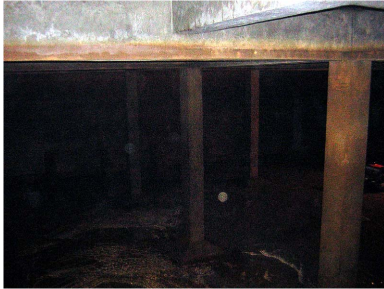
図 1.6 旧貯水池内部(旧トンネル吐出口から撮影)
