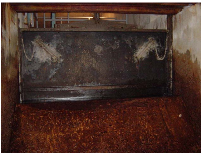
トンネル入口のゲートを下流から見る。左写真はゲートの全景、右写真はゲートの戸当たりから漏水が生じている状況を示す。フィジェ湧水池からの送水の止水や流量制御が確実に行えない。交換が必要。
