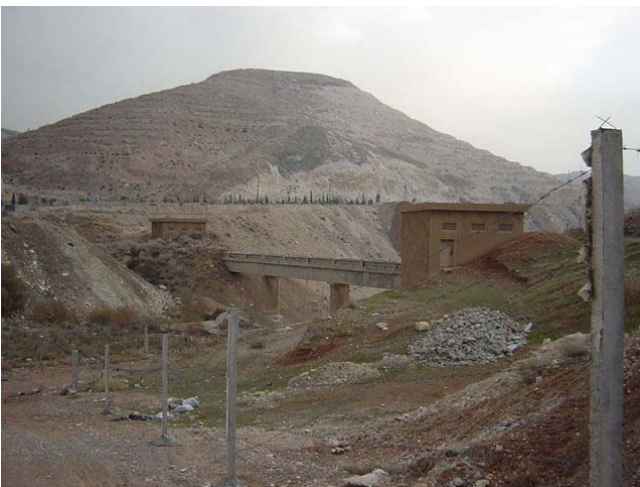
旧トンネルの水路橋 No.3 (橋長 60 m)。1960 年代に外面補強された桁部分の鉄筋が腐食し、鉄筋を被うコンクリートが剥離しているため、補修が必要。
