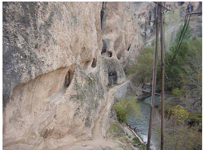
ローマ時代に建設されたフィジェ湧水池からの導水路遺跡。湧水池から約3 km 下流。旧トンネルのゲート No.7 の脇。写真右にはバラダ川が見える。
