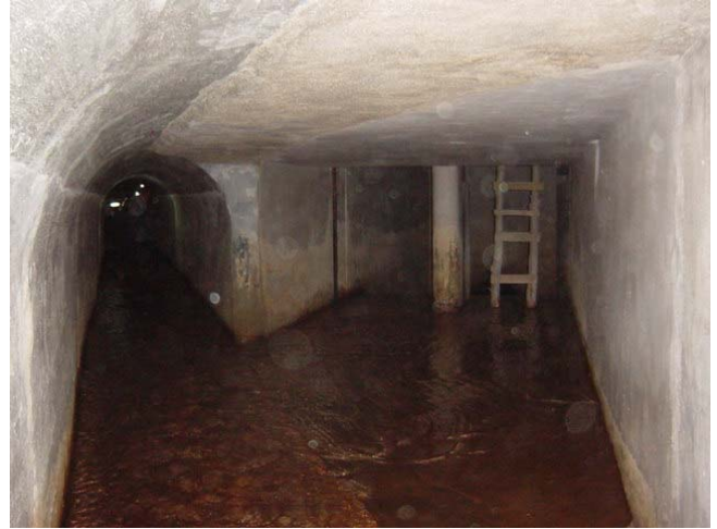
デューマ渓谷を横断するサイフォンパイプ上流部のトンネル分岐部。左側分岐部には 3 本の旧サイフォンパイプが繋がり、右側分岐部には、新サイフォンパイプが繋がっている。
