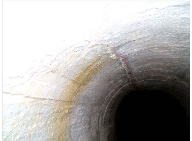
左写真に示す住宅街の直下を通過する旧トンネルで発見された構造的なひび割れ。地質的な岩盤変動の影響もあり、地山補強が必要。
