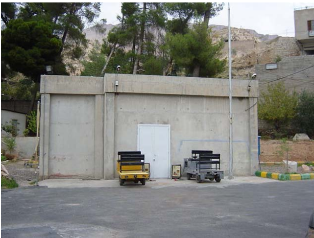
フィジェ湧水池管理所内にある新・旧トンネルの入口建屋と新トンネル内の移動に使用されるバッテリーカー。トンネル入口はこの建屋の下に位置する。
