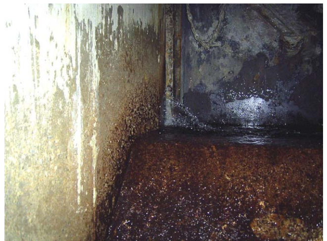
トンネル入口のゲートを下流から見る。左写真はゲートの全景、右写真はゲートの戸当たりから漏水が生じている状況を示す。フィジェ湧水池からの送水の止水や流量制御が確実に行えない。交換が必要。
