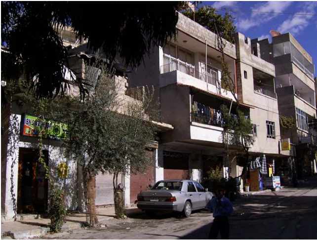
旧トンネルが通過するフィジェ湧水池管理所付近の地表状況。都市化が進展して高層建物が立ち並び、建設当初とは大きく状況が異なる。
