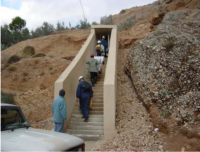
旧トンネル (TD 3,094) に設けられたトンネル入口ゲート No 7。旧トンネルには 9 箇所入口ゲートがある。
