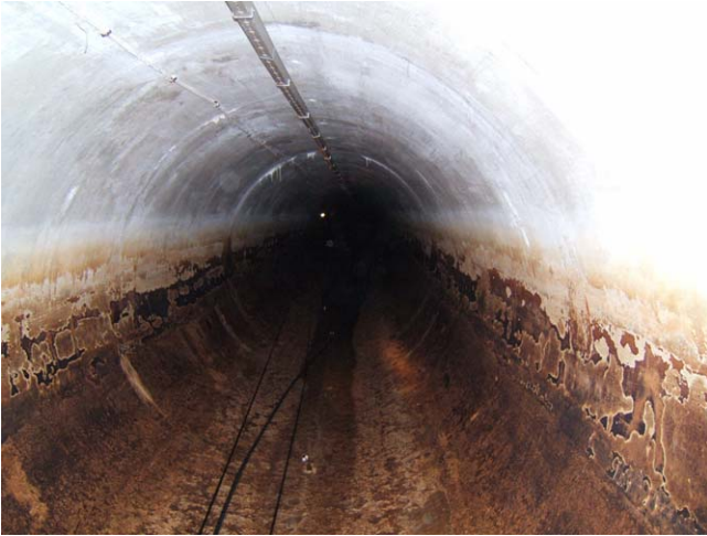
健全な新トンネル部分。直径 2.5 m。
