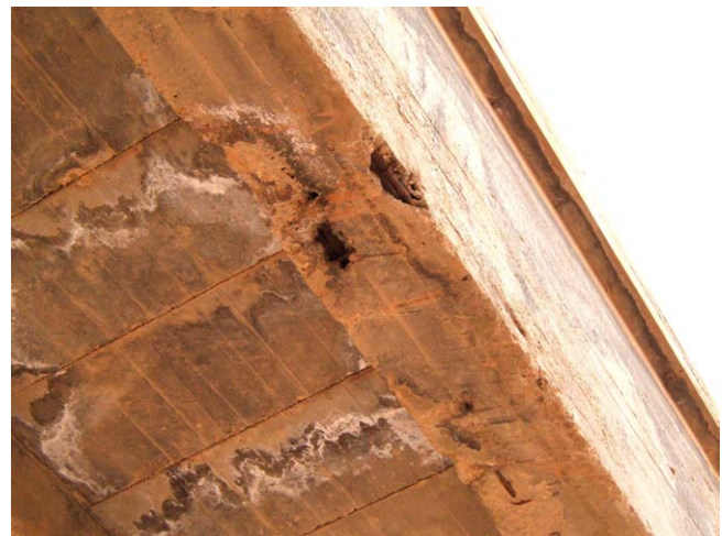
旧トンネルの水路橋 No.3 (橋長 60 m)。1960 年代に外面補強された桁部分の鉄筋が腐食し、鉄筋を被うコンクリートが剥離しているため、補修が必要。
