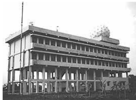
ケプパラ気象レーダ塔
