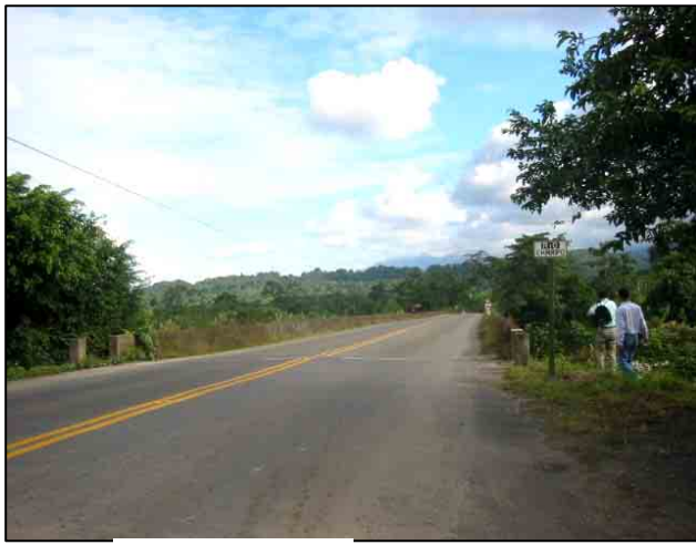
桁の垂れ下がり
