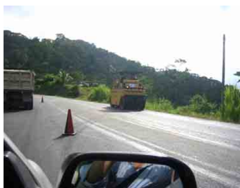
タイヤローラーによる転圧
