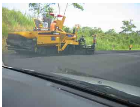
フィニッシャーによる敷き均し
