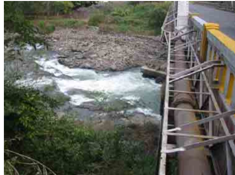
バランカ (Barranca) 橋国道 1 号 (対象 29 橋外)
