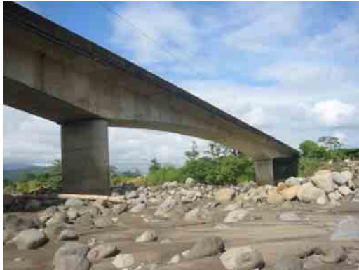
橋梁番号 17 国道 2 号線
