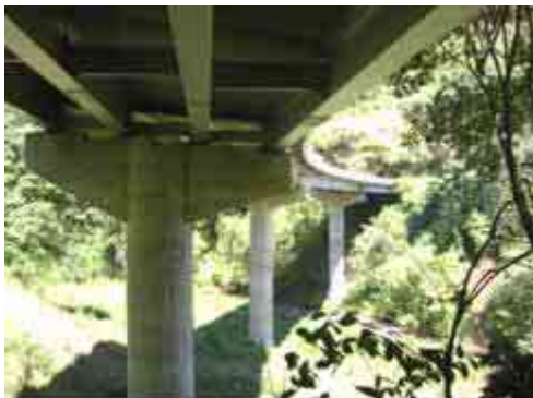
橋梁番号 10 国道 2 号線
