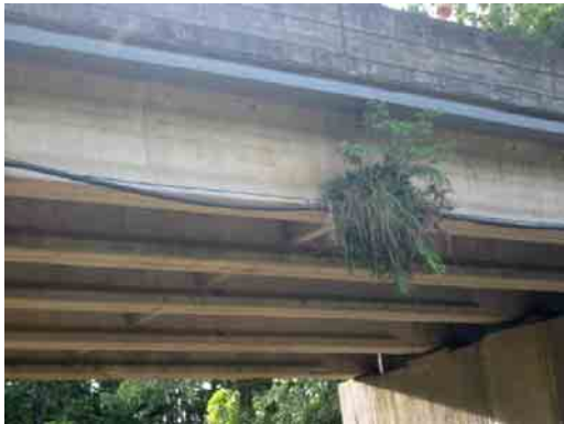
橋梁番号 18 国道 2 号線
