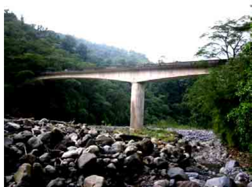
橋梁番号 21 国道 32 号線
