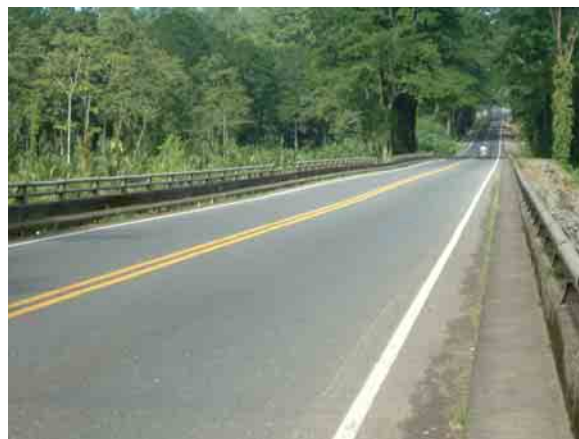
桁の垂れ下がり
