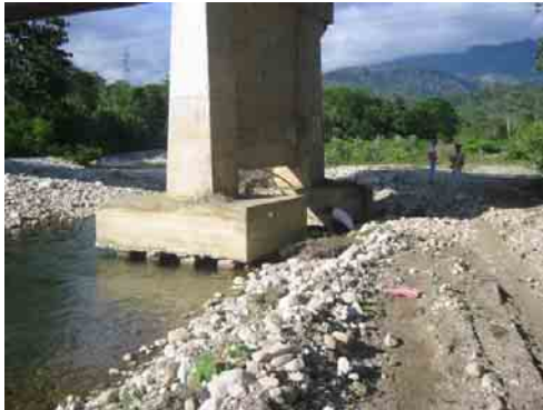
橋梁番号 15、国道 2 号線
