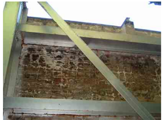
床版のひび割れ
