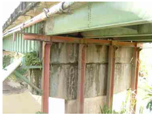
橋梁番号 27 国道 32 号線
