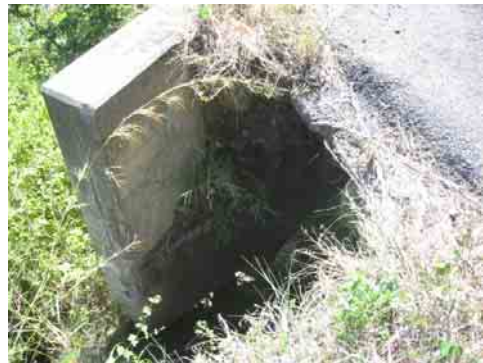
橋梁番号 11 国道 2 号線
