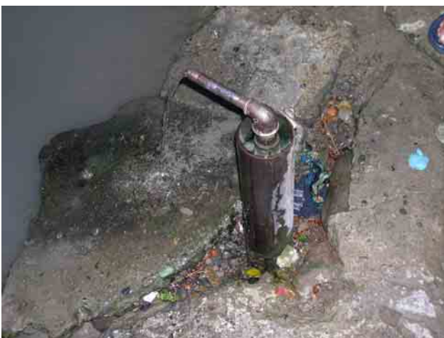
ハマドニ行政区上下水道公社による共同水栓バルブが取れてしまっており、常時開放されている。
