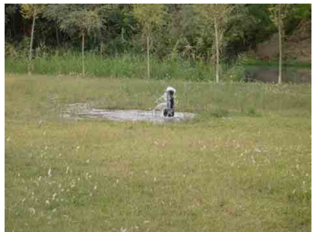
左図給水施設の直近にある自噴井、流し っ放しとなっており、家畜用となってい る。近くにこの様な井戸がもう 1 本あ る。
