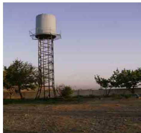
修復された高架タンク（塗装済み）
