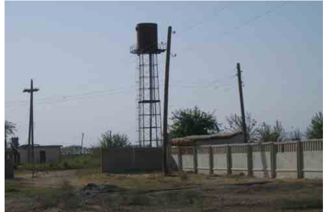
サルハチ農場高架水槽（傾いており、タンク下から漏水している）
