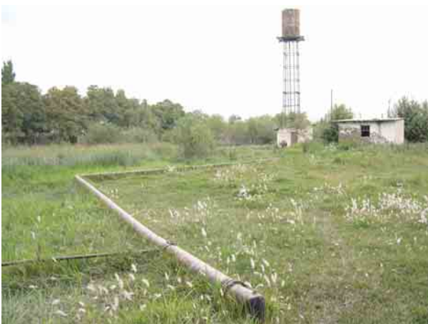
既存給水施設（カリーニン・ジャモワット） 稼動しているが、配電盤、ポンプ、パイプの 改修が必要である。
