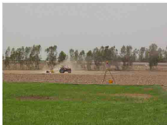
上記場所近隣で、ほ場の均平作業を行っている。
