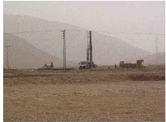
地下水掘削(灌漑電力局が実施)。
