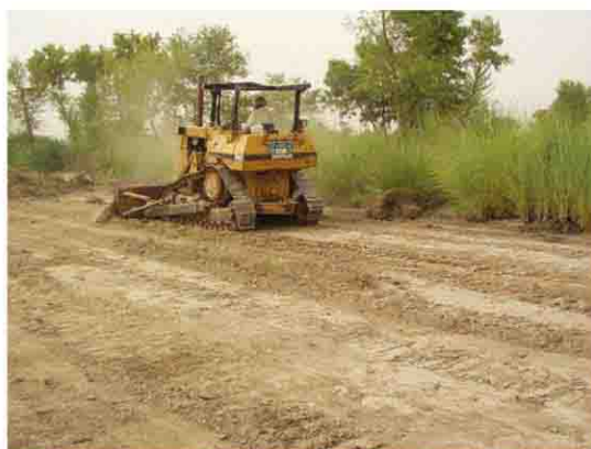
フィッシュポンド造成中のBD。 (ファイサラバードディストリクト事務所の所管)。
