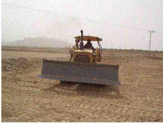
クエッタディストリクト事務所のBD。 クエッタ近郊の石漠を畑地に造成中。
