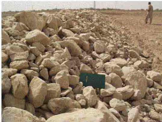
上記造成中に集積された石で築堤された土石塁。 この土石塁で、雨水と土壌の流亡を防ぐ。
