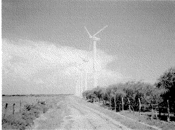
ラベンタ風力発電所（オアハカ州）
