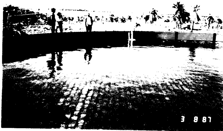
オーストラリア タンク改修工事
