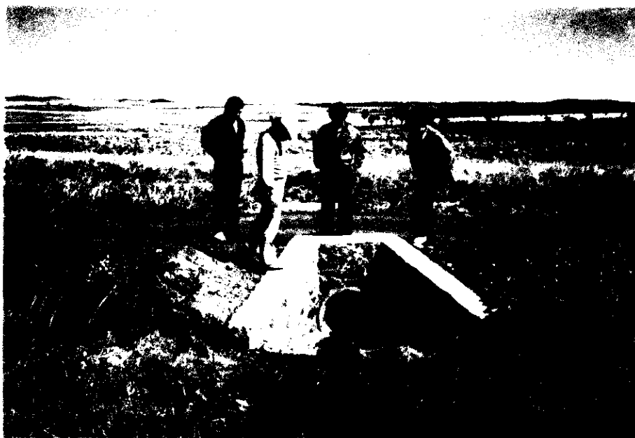
暗渠新設工事
