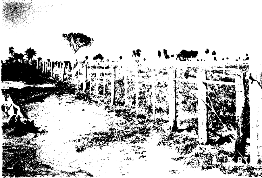
牧柵補修工事
