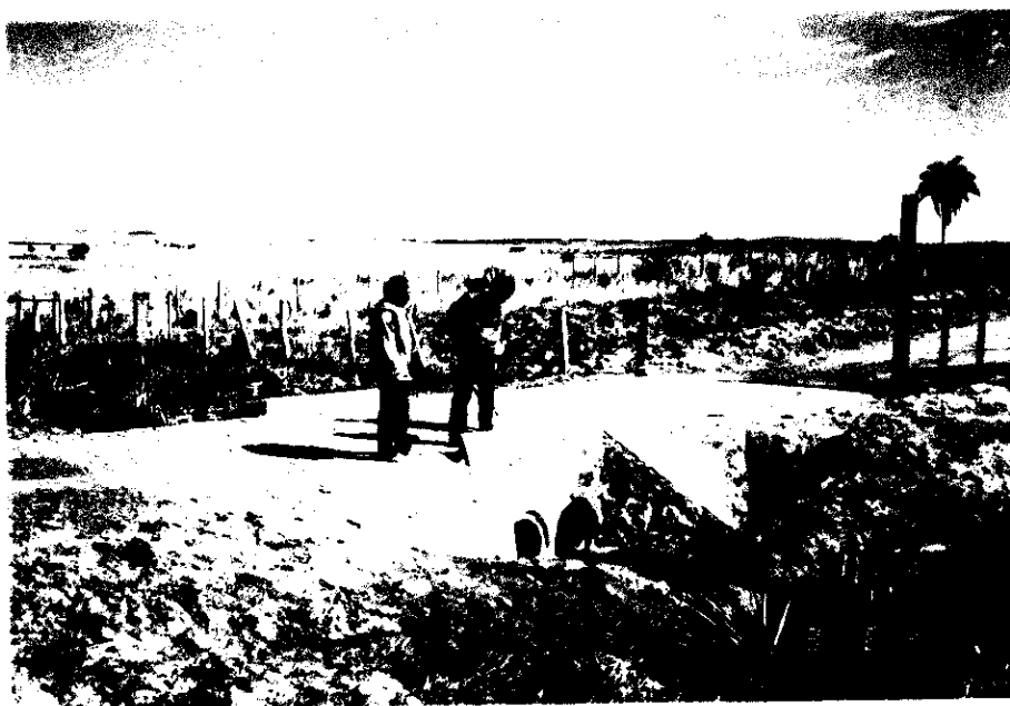
橋 No.2 新設工事
