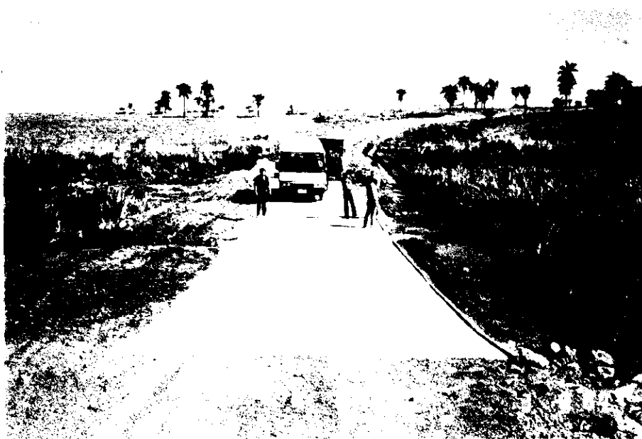
橋 No.1 新設工事
