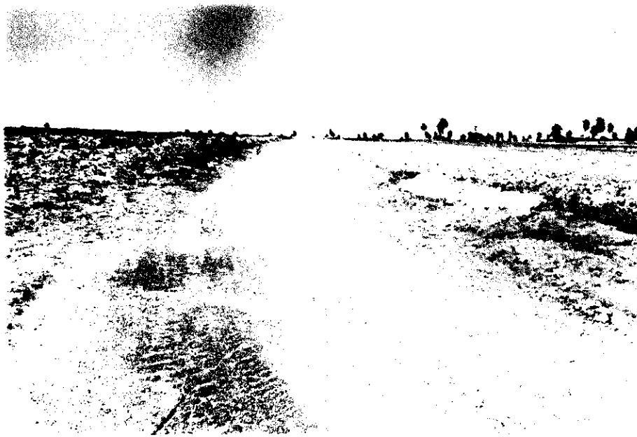
道路新設工事
