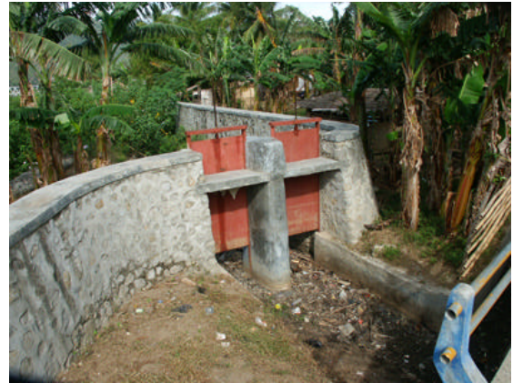
写真 5-4 新設された排水ゲート ゴミ捨て場の存在となっており、 維持管理上の問題が残る。
