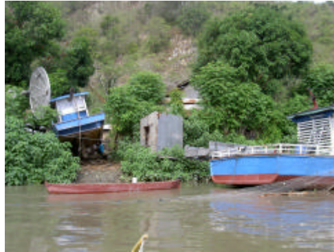
写真 5-10 ボランゴ川右岸下流部にある地元船舶を補修しているドック
