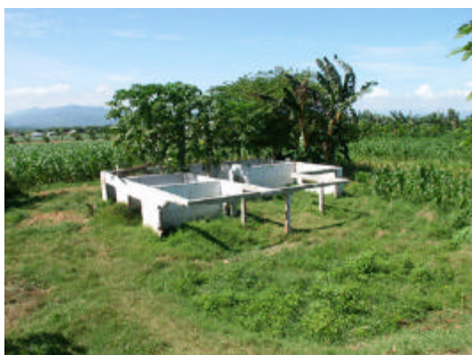
写真 2-1 Alo-Pohu 川河口で土砂により埋没した家屋(1999年-2001年洪水)
