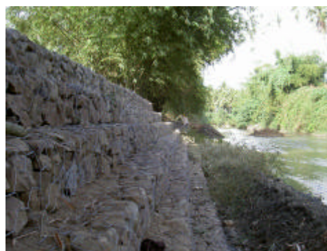
写真 5-2 新設されたフトン籠護岸
