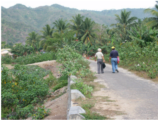
写真 5-3 新規に建設された堤防・護岸
