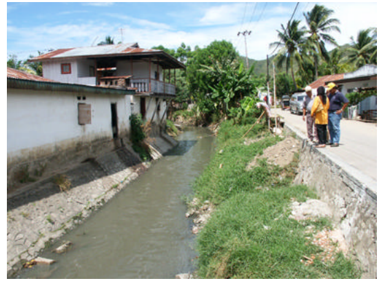
写真 3-2 ビアワオ地区に流入する農業排水路(現在は都市排水路化している)：この先のボランゴ川との合流点で逆流氾濫した
