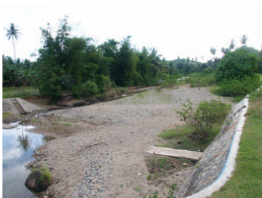
写真 2-4 多大な土砂流出を示す堰下流の土砂堆積 (Biyonga 川 Huludupitango 堰)
