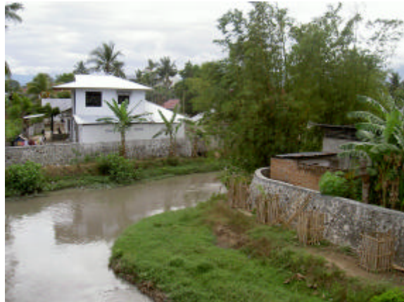
写真 3-4 2002 年洪水後建設されたゴロンタロ市街地のパラペット堤
