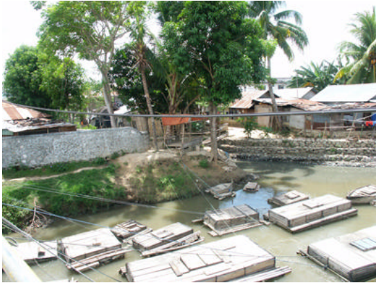
写真 3-1 ビアワオ地区のボランゴ川、流入排水路および湛水原因の一因となった洪水防御壁
