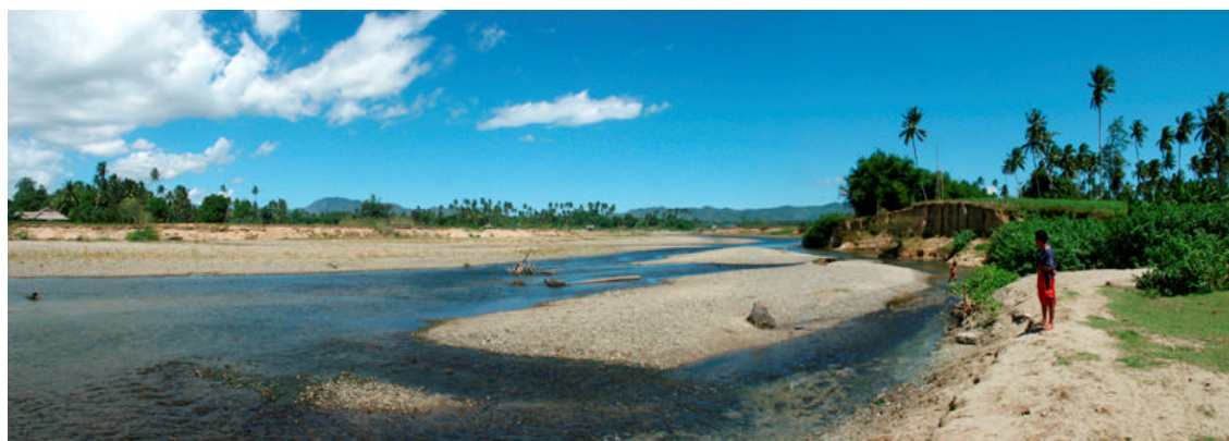
写真 3-3 ボランゴ川上流部の広大な河道と河床低下の状況
