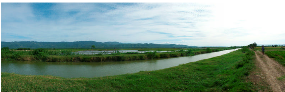
写真 2-3 Alo-Pohu 川：浚渫し築堤したデルタ上の河道
