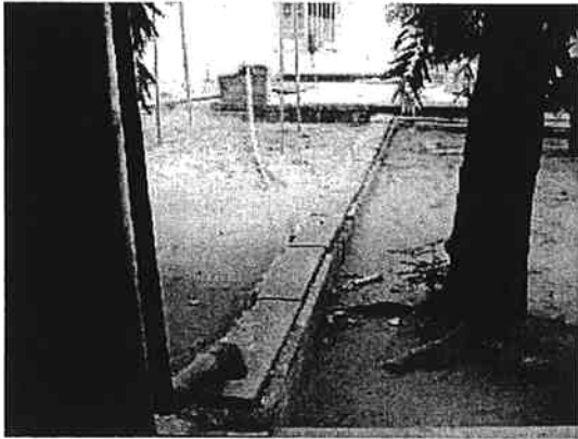
給水設備／天水貯水槽
