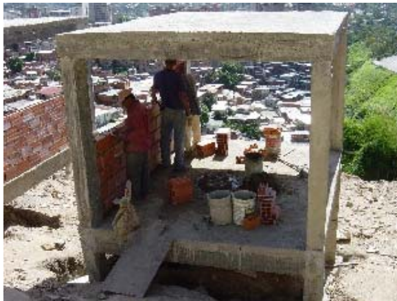
Foto 3.37 Trabajo Pared Ladrillo Arcilla (1)
