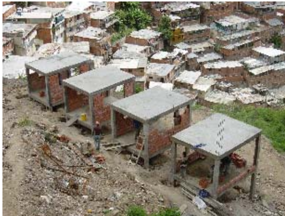
Foto 3.7 Trabajo de Techos
