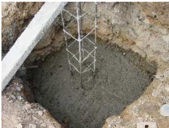
Foto 3.17 Vaciado Concreto para Fundación
