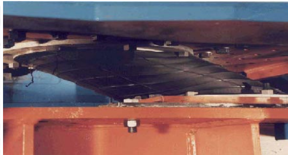
Figura S6-3.2.5 Ejemplo del Reforzamiento del Soporte de Acero
