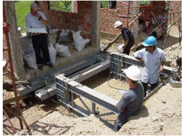
Foto 5.2 Armazón de Acero para Transferencia de Carga
