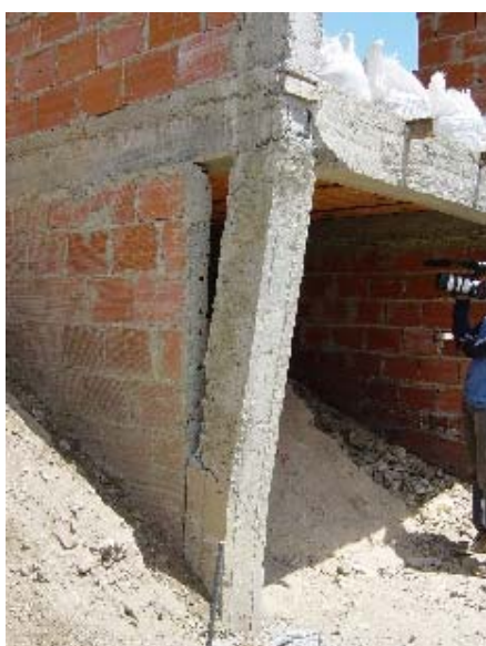
Foto 6.15 Separación de Pared y Armazón
