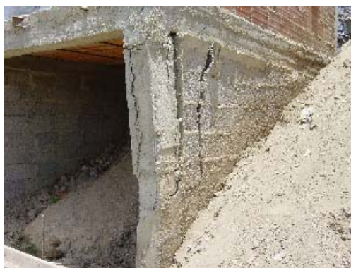
Foto 6.17 Separación Pared Bloque Concreto sin Barras Reforzadas del Armazón
