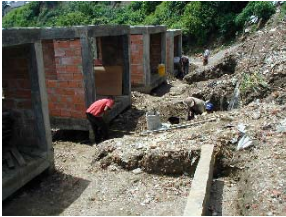
Foto 3.43 Muro de Contención
