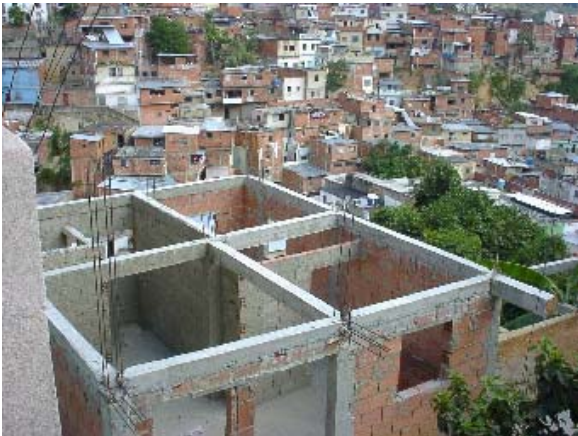
Foto 1.3 Una casa de barrio en construcción
