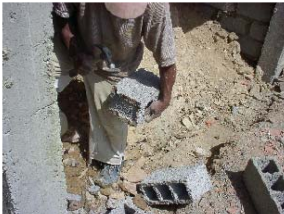
Foto 3.41 Pared Bloque Concreto (1)
