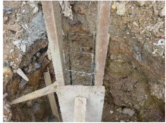
Foto 3.20 Trabajo Encofrado Col. Corta (2)
