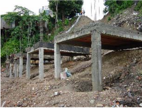
Foto 3.31 Columnas Largas y Piso
