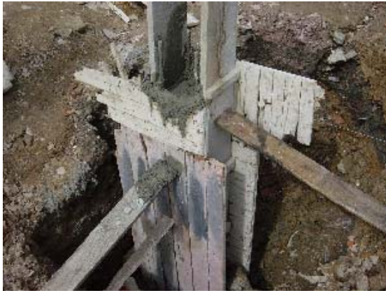
Foto 3.19 Trabajo Encofrado Col. Corta(1)
