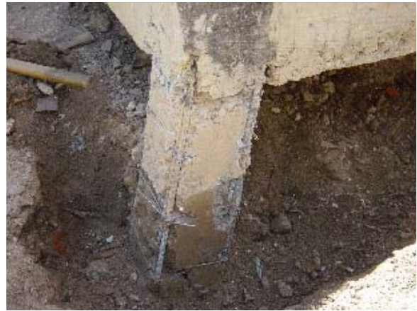
Foto 6.2 Falla Columna Corta Modelo 1 (2)
