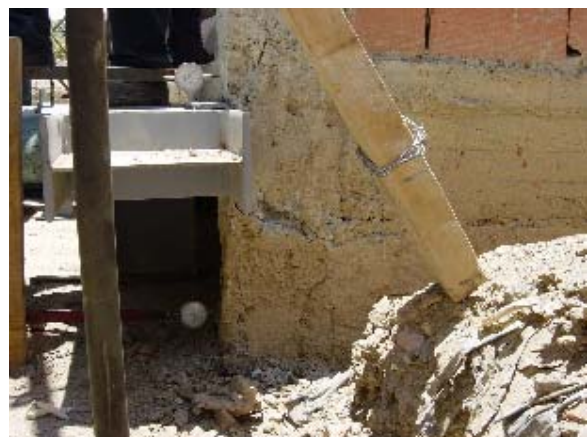
Foto 6.10 Columna Corta debajo Viga de Carga Modelo 2
