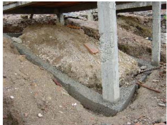
Foto 3.40 Viga de Carga
