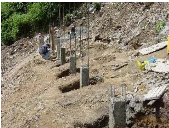
Foto 3.23 Columna Corta Concretada (2)
