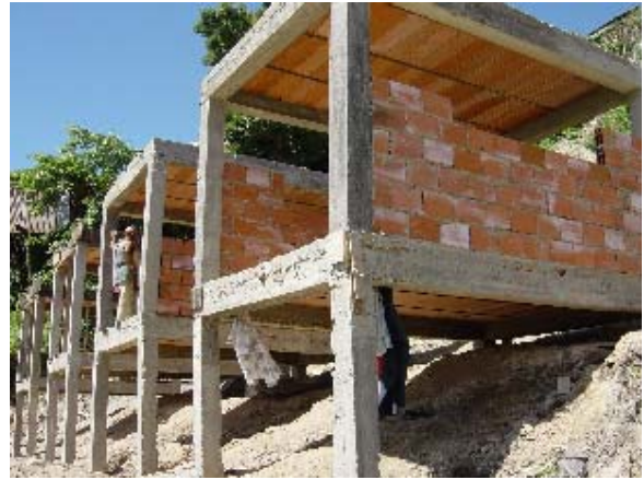
Foto 3.38 Trabajo Pared Ladrillo Arcilla (2)
