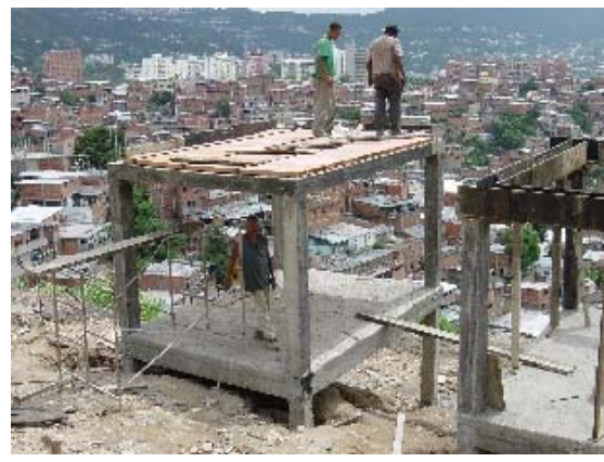
Foto 3.36 Trabajo del Piso del Techo
