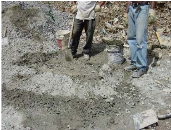
Foto 3.9 Mezclado de Concreto
