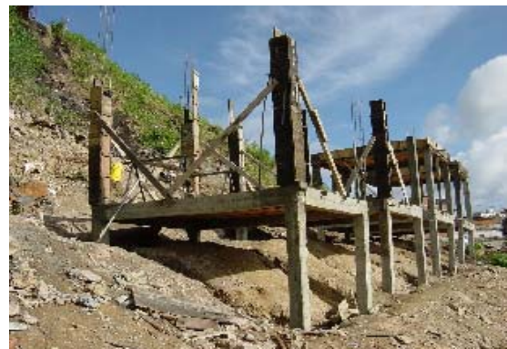
Foto 3.34 Trabajo Encofrado Col. (2)
