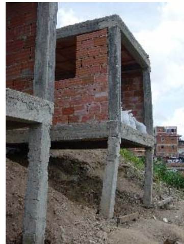
Foto 6.4 Falla Columna Larga Modelo 1
