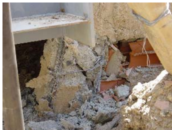
Foto 6.13 Falla por Presión de Columna y Pared Ladrillo de Arcilla (1)
