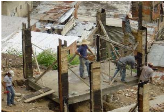
Foto 3.33 Trabajo Encofrado Coll. (1)
