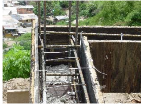
Foto 3.26 Columna Larga Concretada
