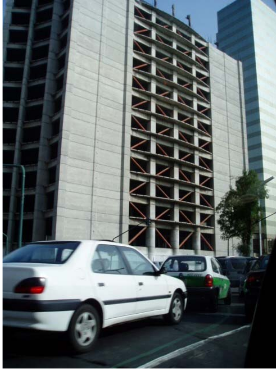
Figura S6-3.2.5 Ejemplo del Reforzamiento del Soporte de Acero
