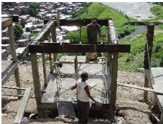
Foto 3.35 Trabajo Encofrado Vigas Techo
