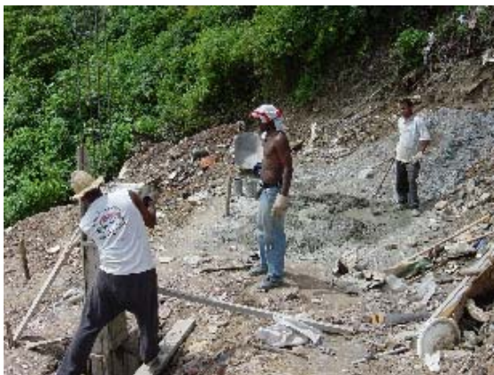
Foto 3.21 Columna Corta de Concreto
