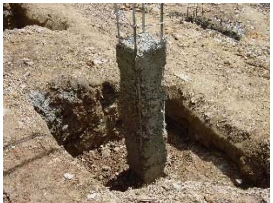
Foto 3.22 Columna Corta Concretada(1)
