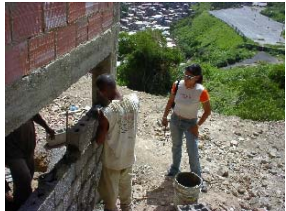
Foto 3.42 Pared Bloque Concreto (2)
