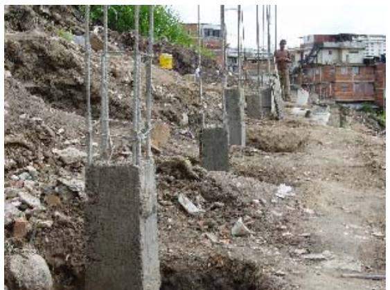
Foto 3.24 Columna Corta Concretada (3)
