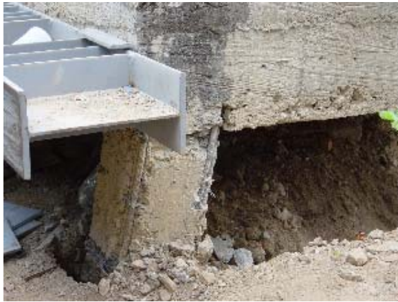
Foto 6.1 Falla Columna Corta Modelo 1 (1)
