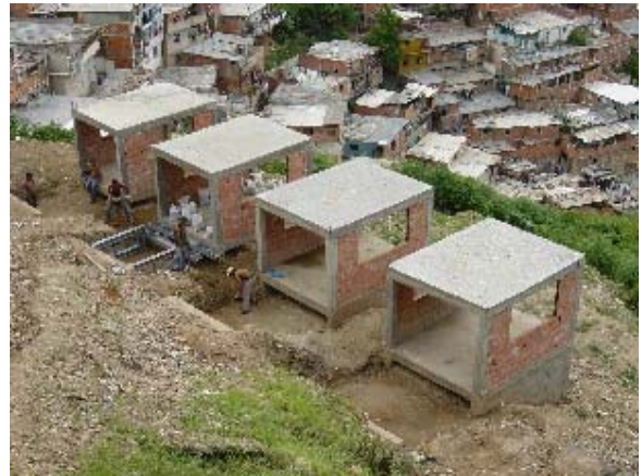
Foto 3.8 Trabajo de Paredes de Ladrillo
