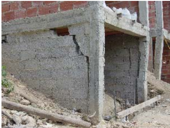
Foto 6.21 Falla Pared Bloque Concreto con Barras Reforzadas
