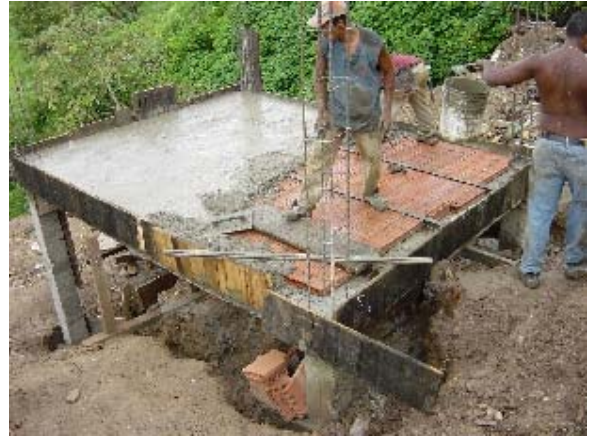
Foto 3.32 Piso de Tabelone de Concreto
