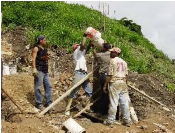
Foto 3.25 Columna Larga en Concreto
