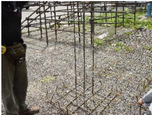
Foto 3.13 Fabricación Barras Refuerzo(1)
