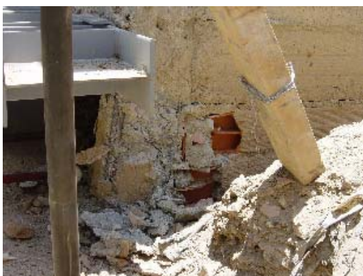
Foto 6.13 Falla por Presión de Columna y Pared Ladrillo de Arcilla (1)
