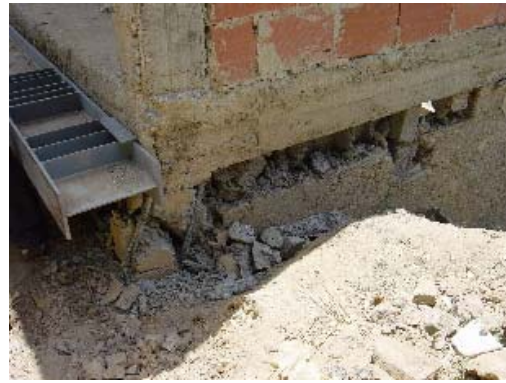
Foto 6.19 Falla de Esquileo de Columna y Pared Bloque Concreto con Barras Reforzadas (1)
