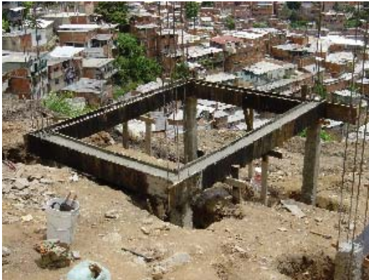
Foto 3.25 Columna Larga en Concreto
