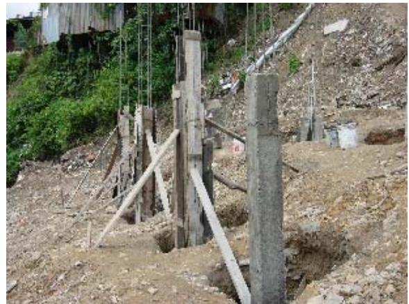
Foto 3.26 Columna Larga Concretada
