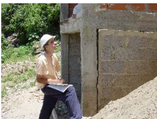
Foto 6.17 Separación Pared Bloque Concreto sin Barras Reforzadas del Armazón
