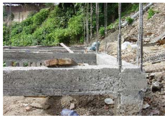
Foto 3.28 Instal. Barras Refuerzo de Viga
