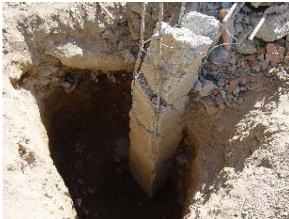
Foto 6.3 Falla Columna Corta Modelo 1 (3)
