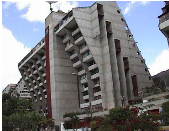
Figura S6-1.2.2 Pared de Corte con Estructura de CR
