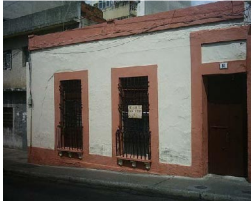
Figura S6-1.2.7 Estructura de Ladrillo de Concreto
