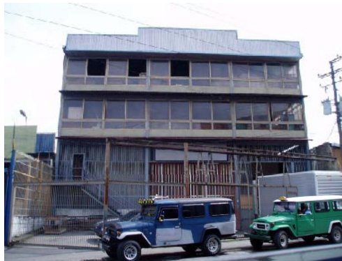
Figura S6-1.2.5 Pórticos a Momento Resistente de una Estructura de Acero
