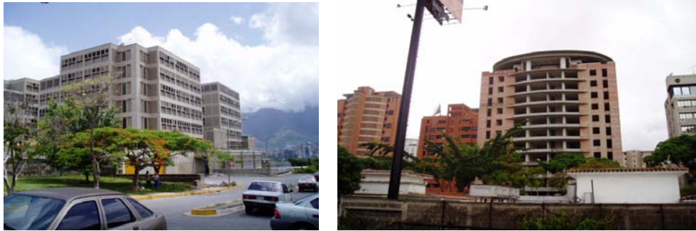
Figura S6-1.2.1 Pórticos a Momento Resistente con Estructura de CR
