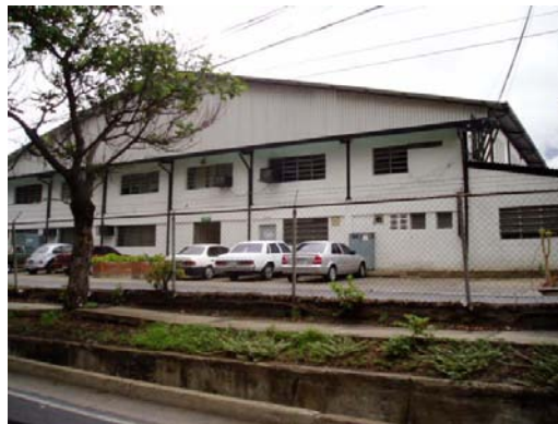
Figura S6-1.2.6 Estructura de Acero Liviana
