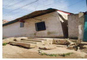
Vivienda Dañada en Antimano
