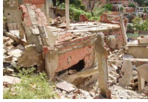
Vivienda Dañada en 19 de Abril
